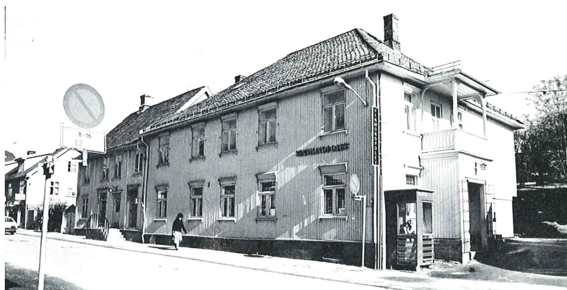
Storgaten 10, tidligere Telegrafbygget.
