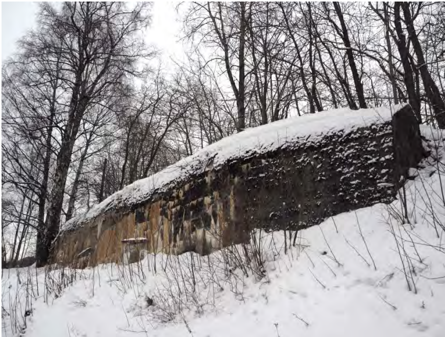
Bunker fra andre verdenskrig, bygget av den tyske okkupasjonsmakten. Foto: NIKU 2017.
