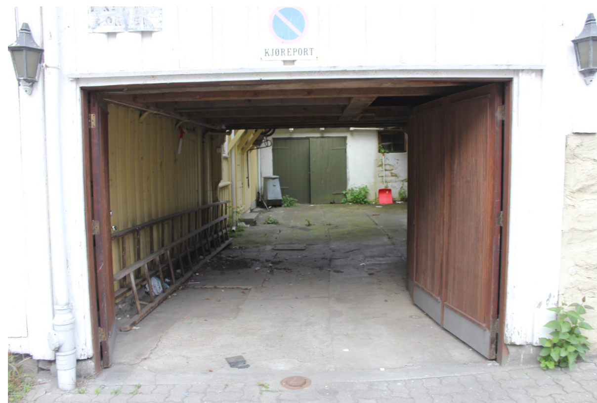
Inngang til garasjen Havnegaten 8, fra Storgata.
