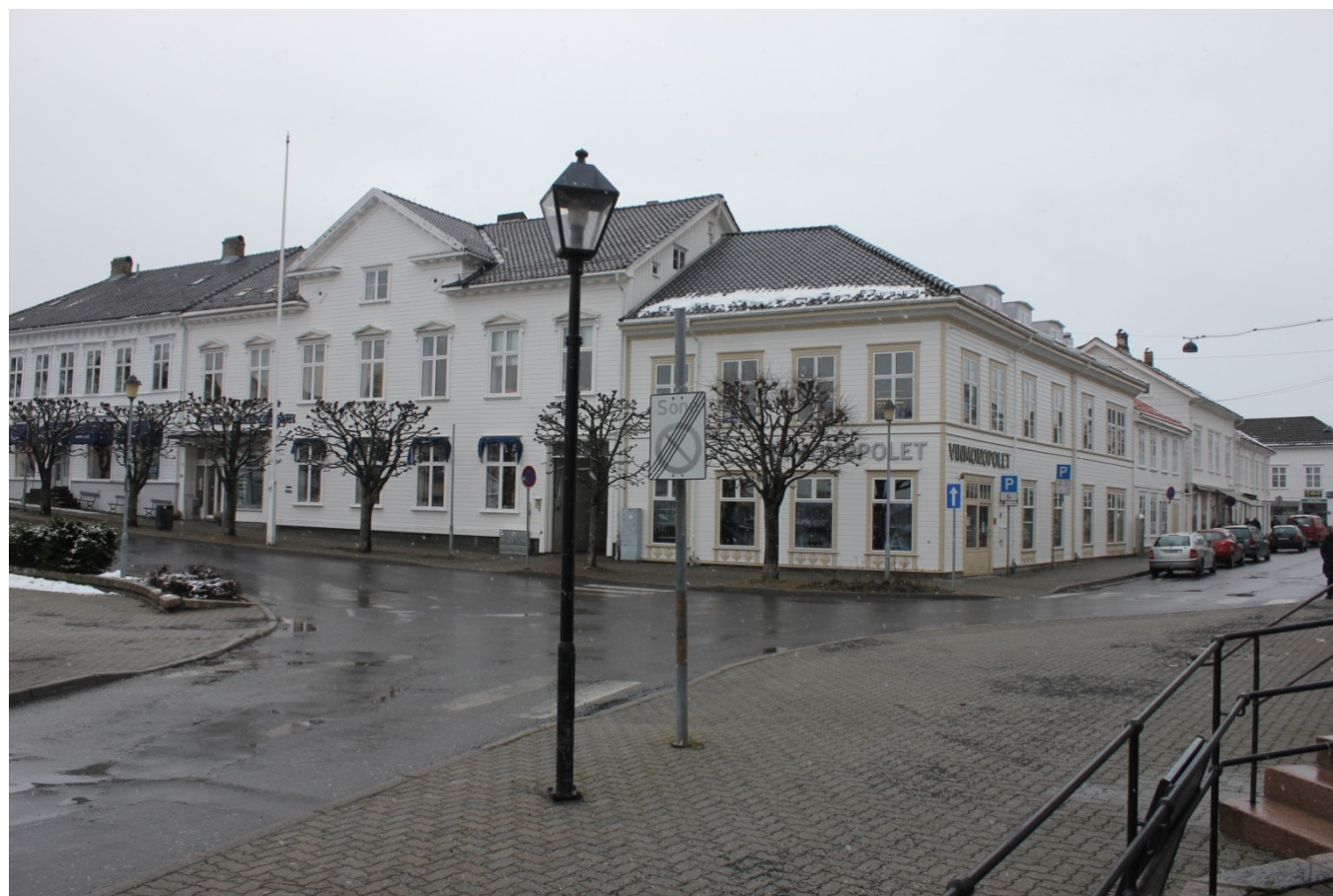
Bankens lokaler midt i bildet, med påbygd ark.
