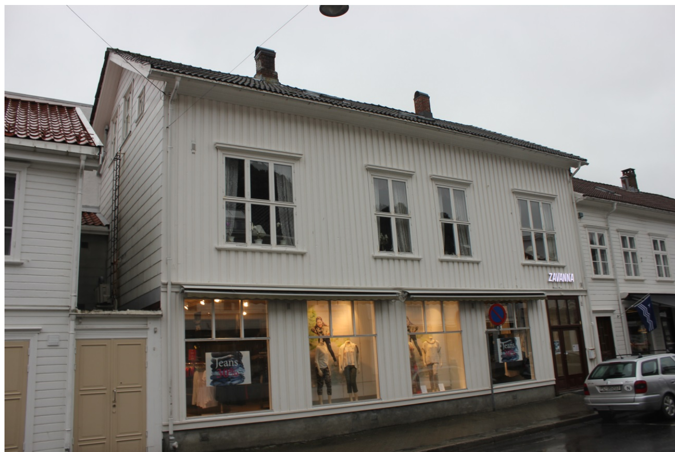
Havnegata 6. Noen eksempler på fasadeendringer er blant annet platene på gavlveggen mot Havnegata 4 og det stående panel i fasaden mot Havnegata.
