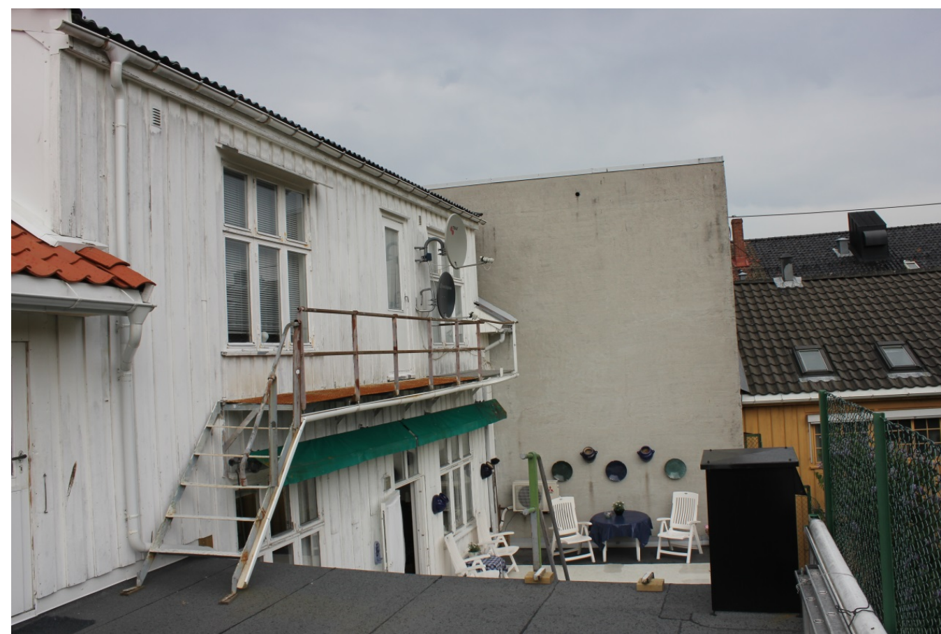
Påbygg i betong på baksiden av Havnegata 4.
