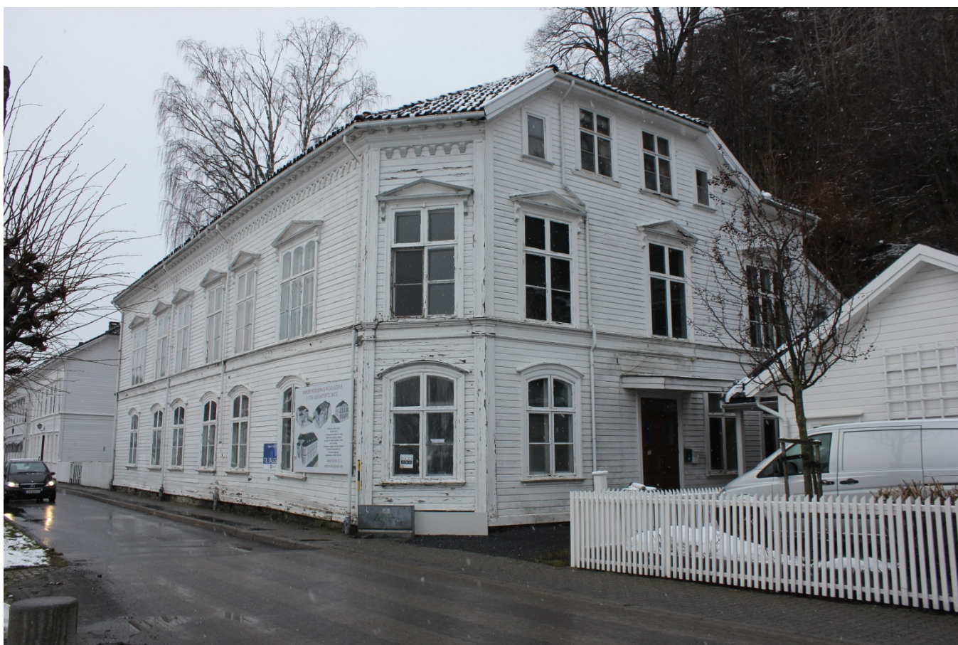
Bygning på Solsiden, oppført etter brannen i 1861, med brukne takflater og hjørner som bygninger som lå som hjørnegårder ut mot andre gater skulle ha. Dette i forhold til brannsmitte ved at ilden lettest tok tak oppunder et møne.
