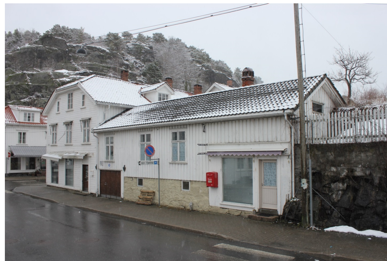
Havnegata 8 og Storgata 8, sett fra Storgata.
