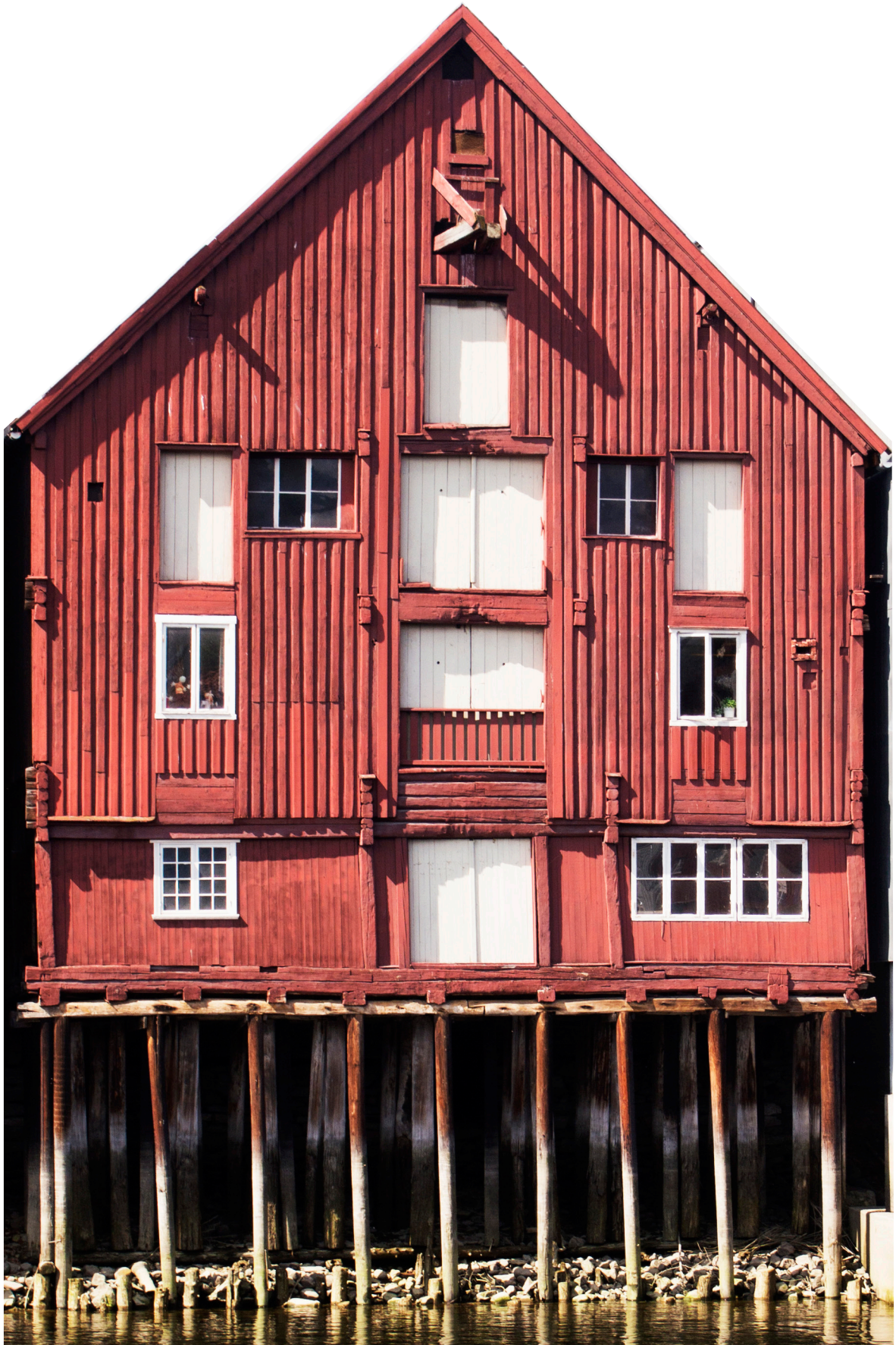
Bryggenes utfordringer: Brannkrav, lave etasjehøyder, manglende lysinnslipp, uisolerte konstruksjoner og utfordringer knyttet til universell tilgjengelighet er noen av utfordringene knyttet til bruk opp i mot gjeldende regelverk. Kjøpmannsgata 29. Foto: Bjørg Helene Andorsen
