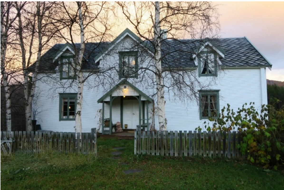
Foto: Ståle A. Bergås, Riksantikvaren
