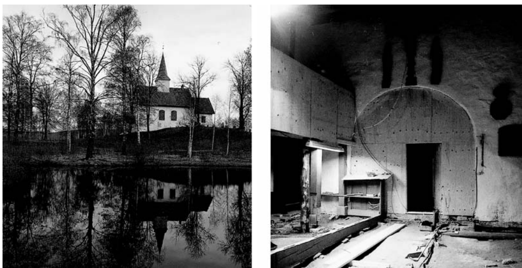
Figur 5.7 Skoger gamle kirke i Drammen hadde stort behov for vedlikehold. Med råte i gulv og tak og hussopp i treverket, måtte det omfattende restaureringsarbeider til. Kommunen tok økonomisk ansvar og bygningen er nå satt i stand.
