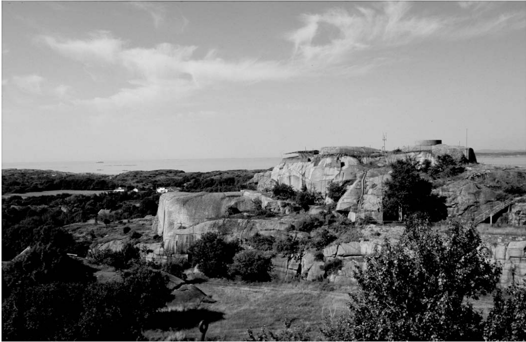
Figur 5.5 Torås fort på Tjøme ble anlagt 1939 som en del av Oslofjordens befestning. Deler av fortområdet driftes i dag av kommunen og brukes som friluftsområde for befolkningen.
