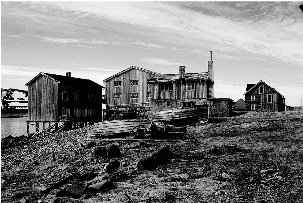
Figur 3.5 Vedlikehold av bygninger som ikke lenger er i bruk, er kostbart. Et kulturminnefond vil kunne
