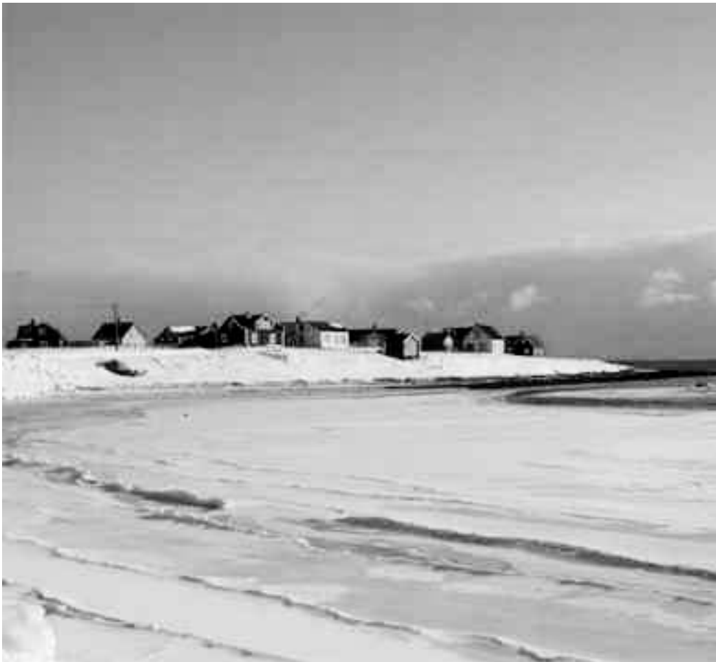
Figur 8.3 | Nord-Troms og Finnmark gikk svært mange bygninger tapt under andre verdenskrig, og for befolkning her knytter det seg store kulturhistoriske verdier til de bygninger som står igjen. Den kvenske bygda Skallelv er et kulturmiljø med mange bygninger som er eldre enn fra 1945.
