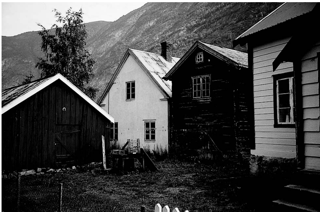
Figur 7.3 Vedlikehold og istandsetting av kulturhistoriske bygninger krever store ressurser som museene ikke alltid har. Midler må tilføres museumssektoren slik at bygningene får et tilfredsstillende vedlikeholdsnivå.
