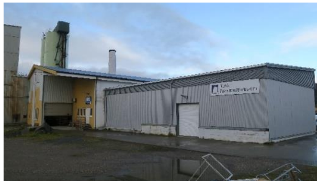
Lagerbygning fra 1948, sett mot nordvest.
