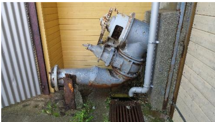
Detalj av transportbandet som er koblet med mateskruen på andre siden av veggen.
