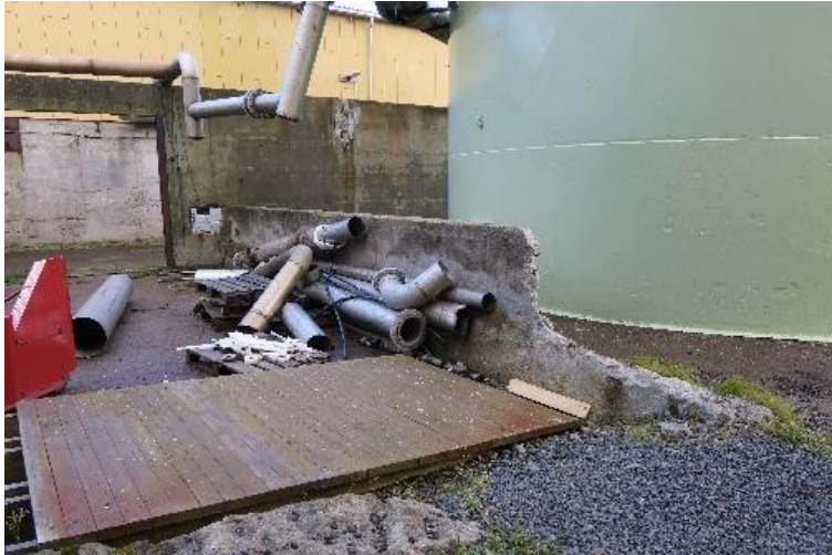
Rester av vegg ved syklontårnet, og rør tilhørende transportkanalen, sett mot nord-nordøst.
