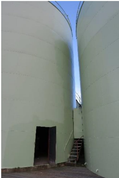
Trapp opp langs tanksiden. Avstengt med dør, sett mot nord.
