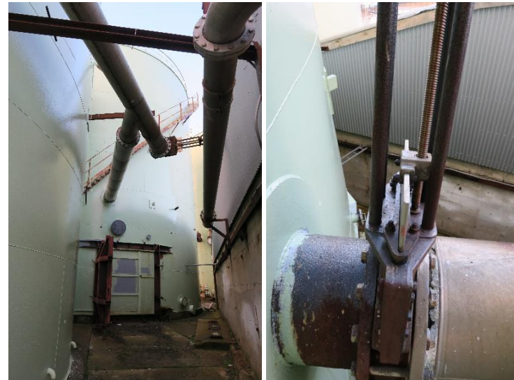
Transportkanal i området mellom råstofftanker og råstoffbinge fra 1950 med pulttak.
