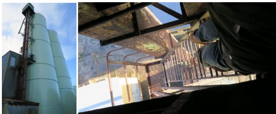
Tv. sett mot sørvest. Th. trapper/leider opp mot boks med transportband på taket av syklontårnet. Trapper i stål, mellomnivåer i strekkjern.
