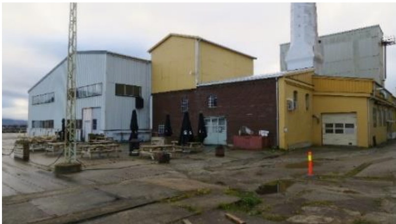
Trandamperi fra 1910, sett mot sørøst.
