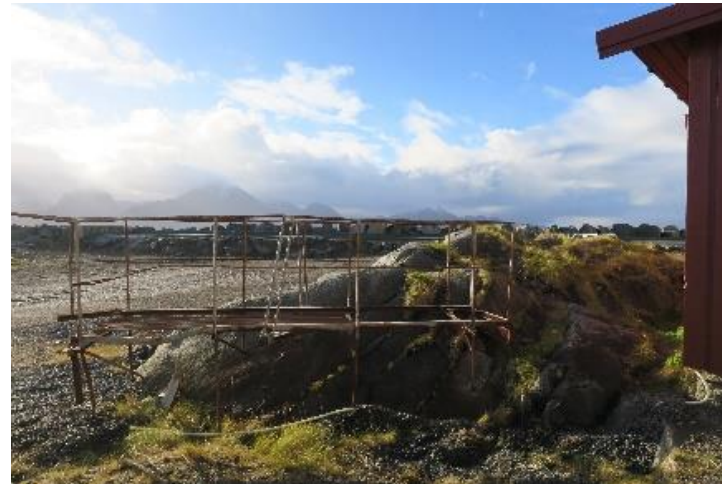
Rester av gangbro til utedo, sett mot vest. Gnr/bnr 52/33.
