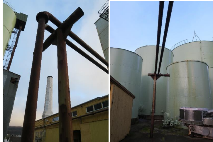
Rester av transportkanalen.
