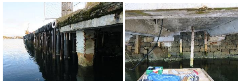
Fundament for tre- og betongkai.
