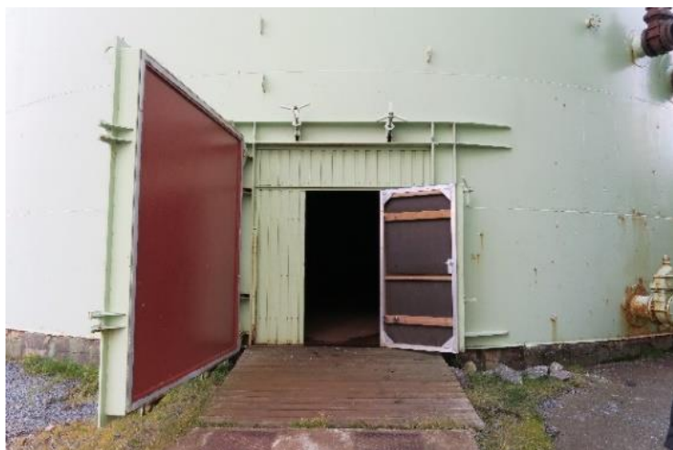
Opprinnelig port i stål med ny dør i tre innenfor, sett mot nordvest.
