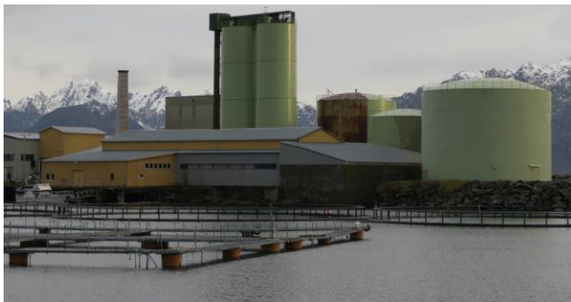
Lagerbygg, gnr/bnr 52/199, bygningsnummer 189863683, sett mot sørøst.
