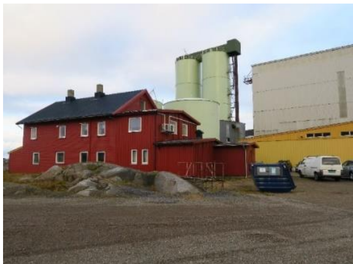
Administrasjonsbygg, gnr/bnr 52/33, bygningsnummer 189863691, sett mot nordvest.
