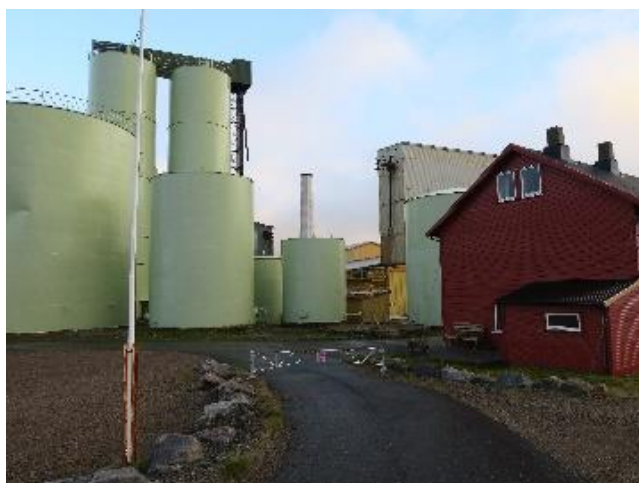
Andre tank fra venstre, sildoljetank 1 fra 1974, gnr/bnr 52/33, sett mot nordvest.
