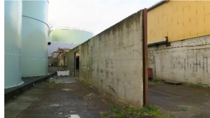
Rester av vegg til råstoffbinge, sett mot vest. Gnr/bnr 52/33.
