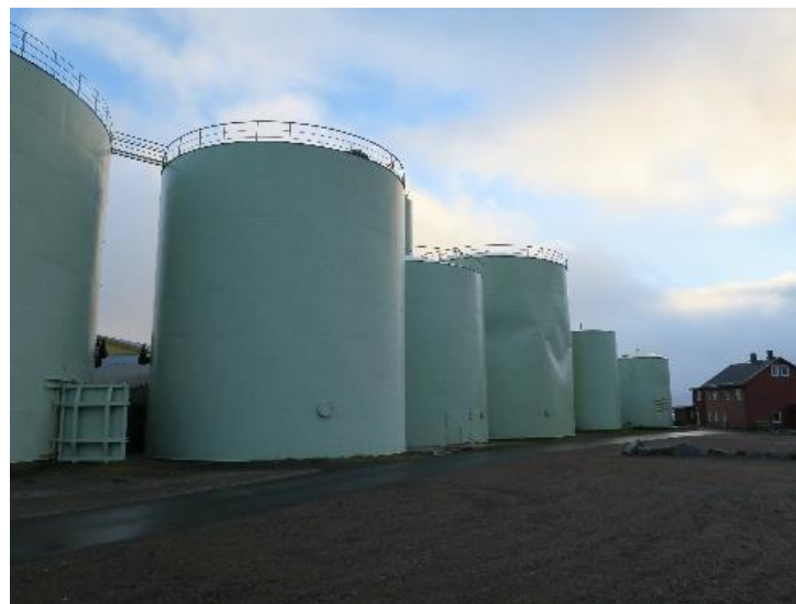
Råstofftank 2 fra 1972, gnr/bnr 52/33, sett mot nordøst.
