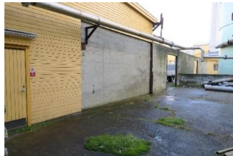
Råstoffbingen sett mot nordvest, og rør knyttet til transportkanalen.
