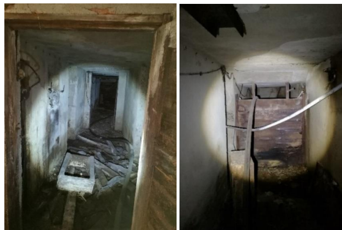
Feltlasarett og tilfluktsrom under fabrikkbygningen. Gnr/bnr 52/33. Th. muligens en lukket utgang/rømningsvei.
