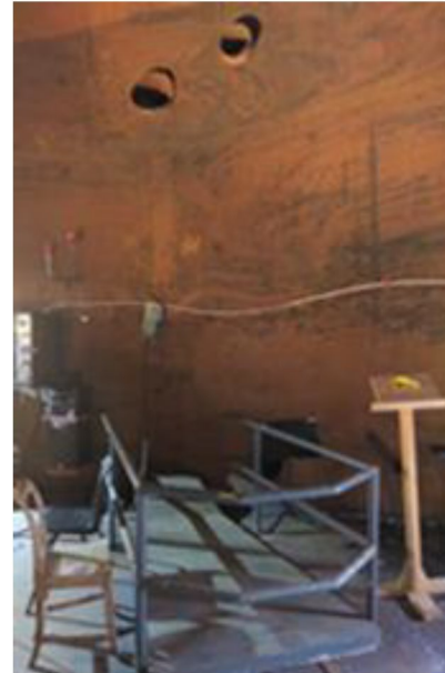
Mateskrue under beskyttende tredekke og med gelender i metall, sett mot nord.
