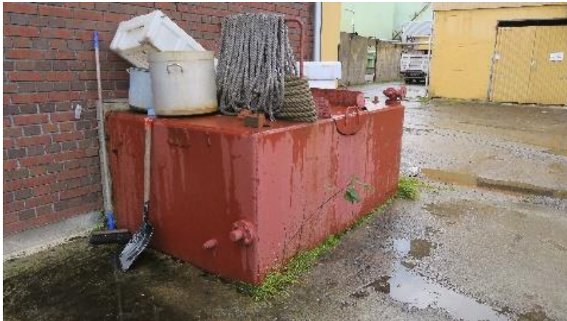
Råstofftank for trandamperiet, sett mot sørøst (11.3).
