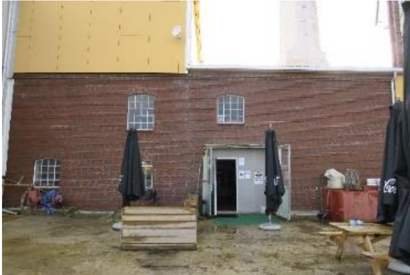
Trandamperi sett mot sør.
