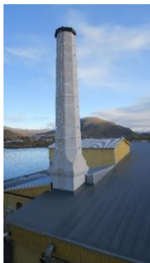
Pipa sett fra syklontårnet mot nordøst.
