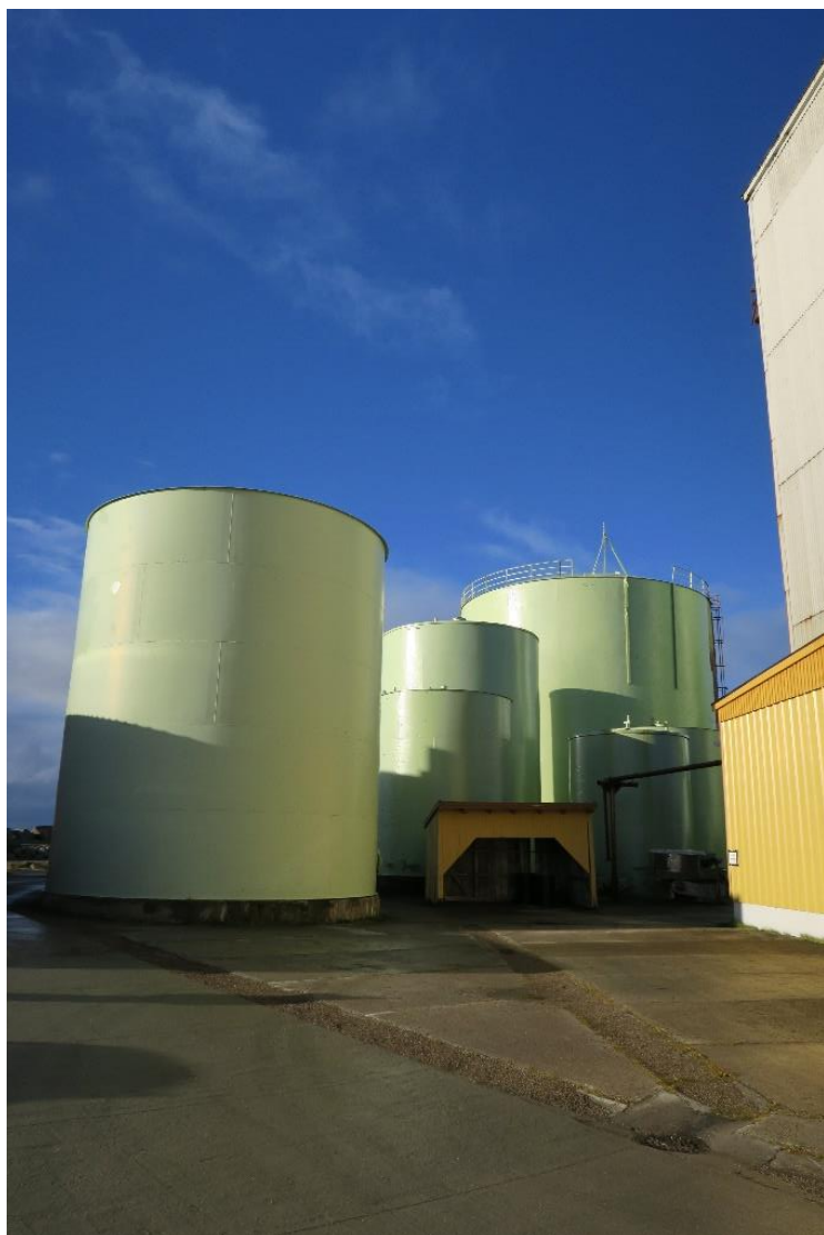
Betongdekke mellom bygget for evaporatorene og administrasjonsbygget, sett mot vest.
