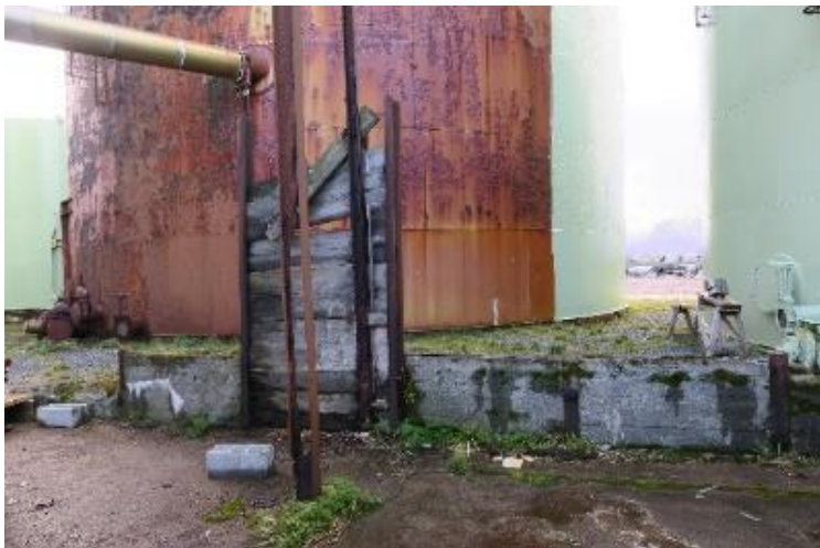
Rester av vegg. Denne viser hvordan veggene ble bygget opp og ned etter behov, sett mot sør. Se lignende vegger i lagerbygningen i tilknytning til fabrikk.
