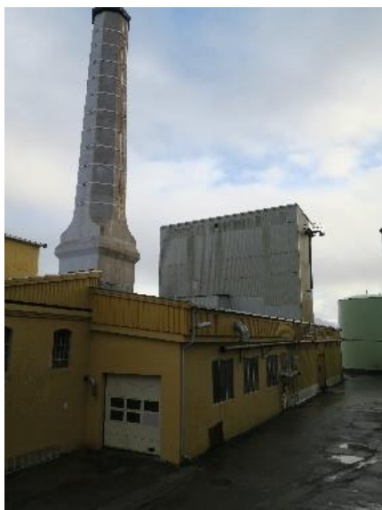
Port til «bilverksted» sett mot sør.
