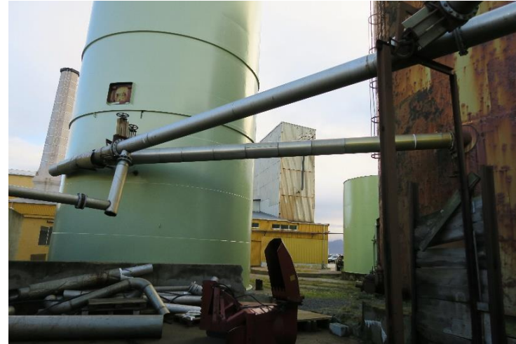
Rester av transportkanalen, sett mot fabrikkpipa og bygget for evaporatorene.
