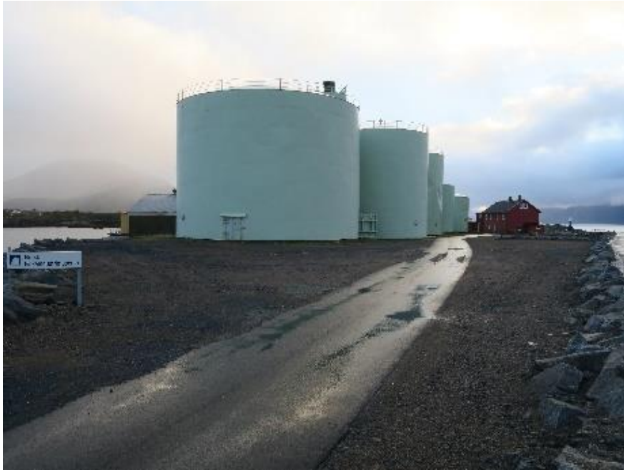
Råstofftak 1 fra 1973, sett mot øst, gnr/bnr 52/33.
