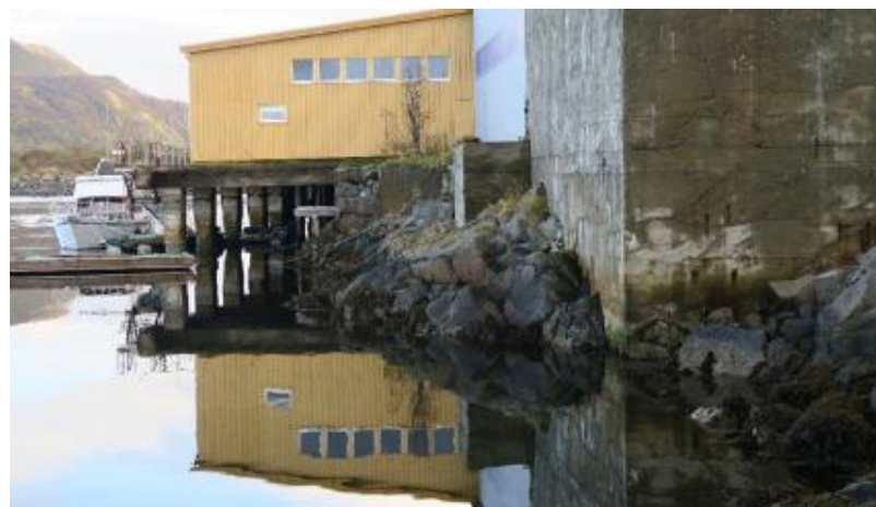
Kaiskuret sett mot øst.
