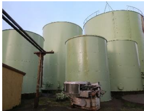
Bunkertank 2 fra 1975, nærmest kamera, gnr/bnr 52/33, sett mot nord.
