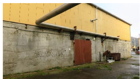
Tv. port mot sør. Th detalj av transportband til høyre for porten, den er koblet til en mateskrue på andre siden av veggen.
