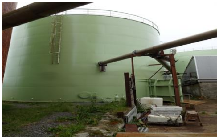
Råstofftank 3 fra 1973, gnr/bnr 52/33, sett mot sørvest.
