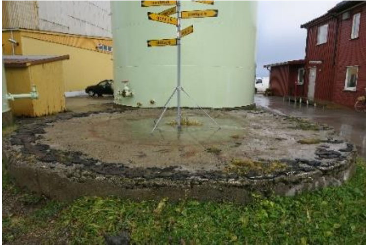
Betongfundament nær administrasjonsbygg.
