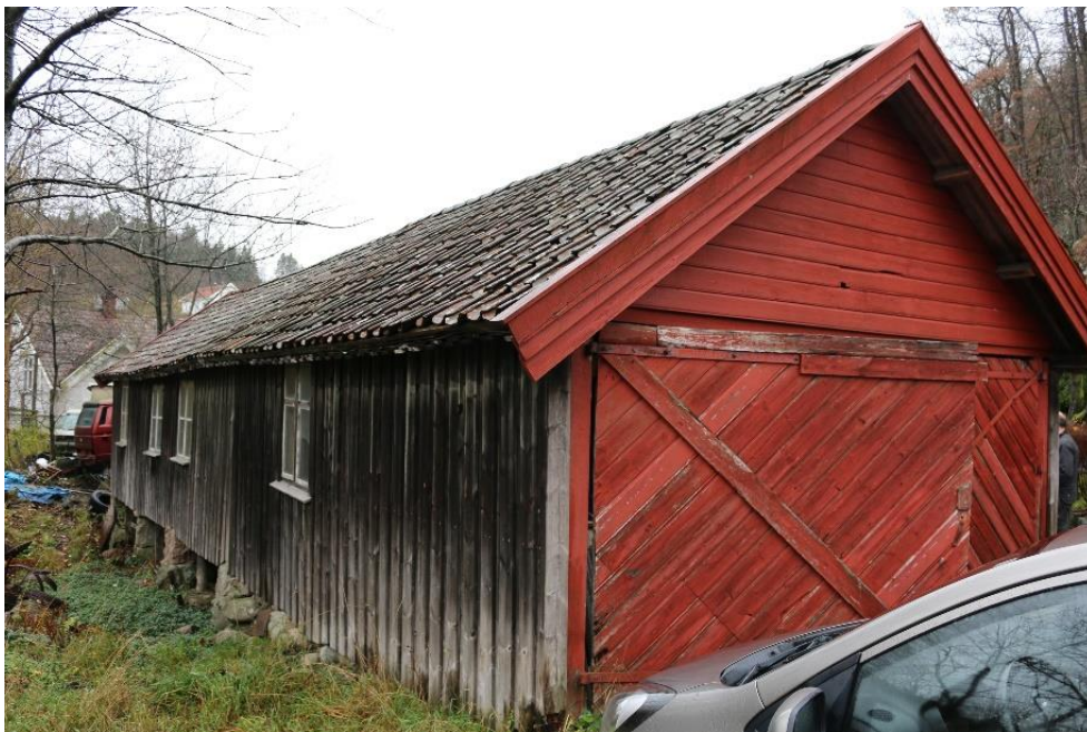
Bussgarasjen med østre gavlvegg og vegg mot sør.
