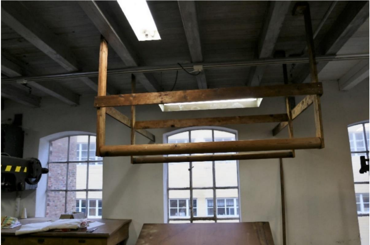
Innretning for oppheng av tøy. Sett mot spinneribygget. Større løst inventar: Hengende armatur.
