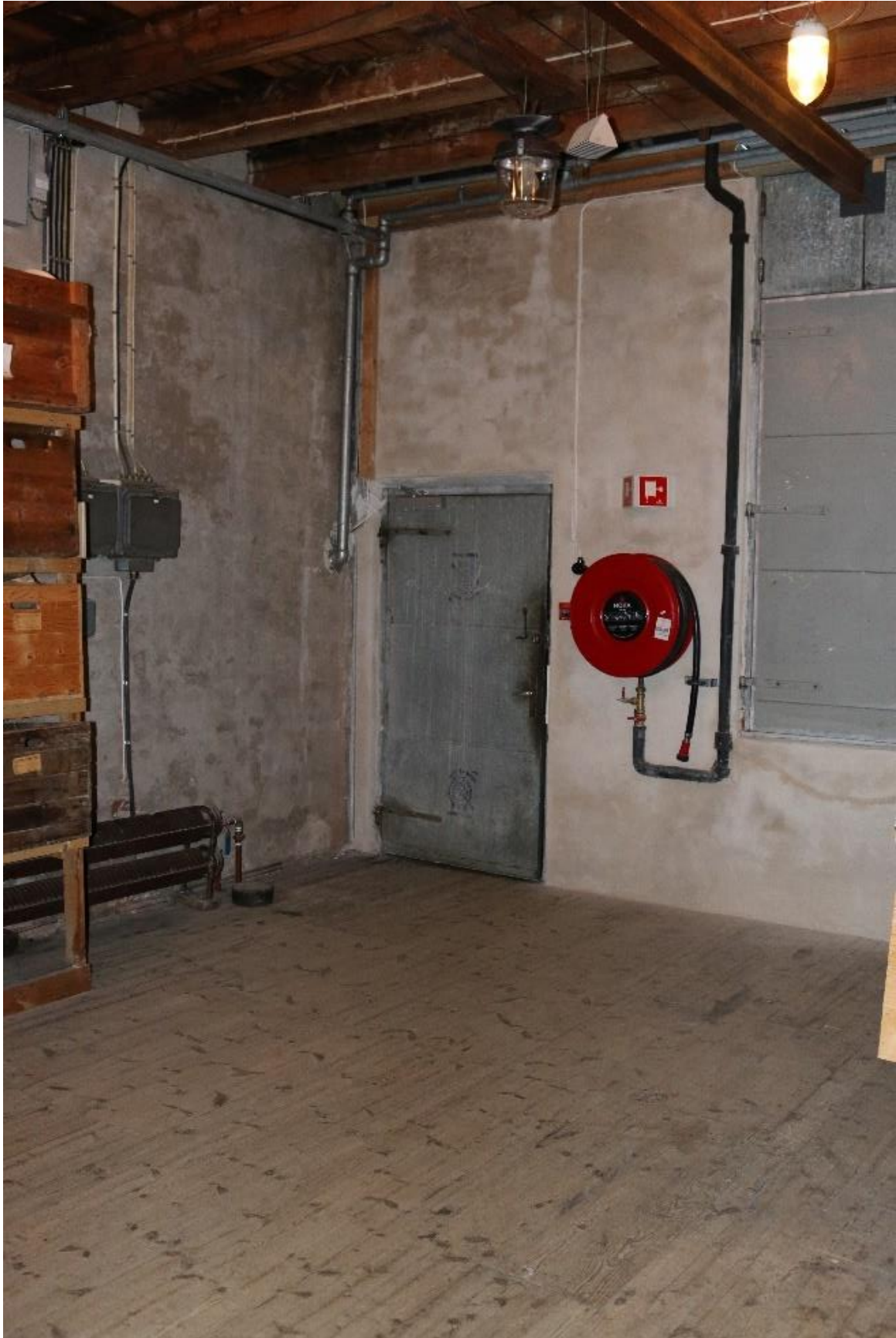
Garnlageret sett mot nord. Døra leder til passasjen over til spinneribygget.
