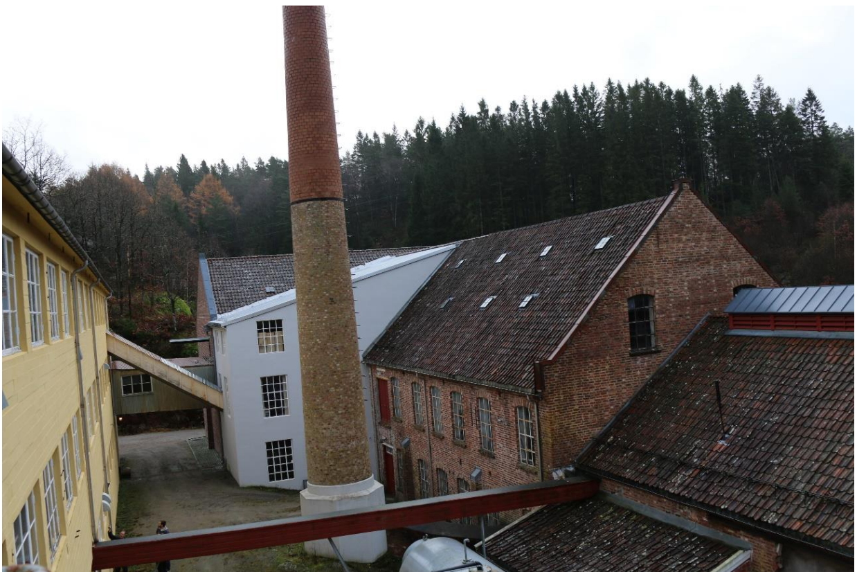
Teglsteinsbygning bakerst i bildet, her vises takvindu på kontorbygg og vinduet i passasjen mellom kontorbygg og spinneribbygg.
