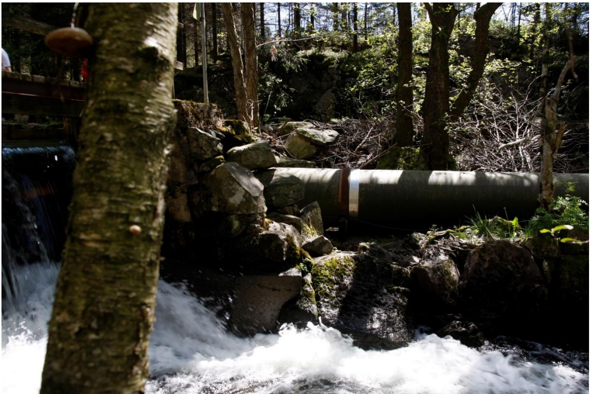
Rørgata ved Stuvoandammen, sett fra nord. Foto: Ulf Gustavsson, Riksantikvaren 2015.
