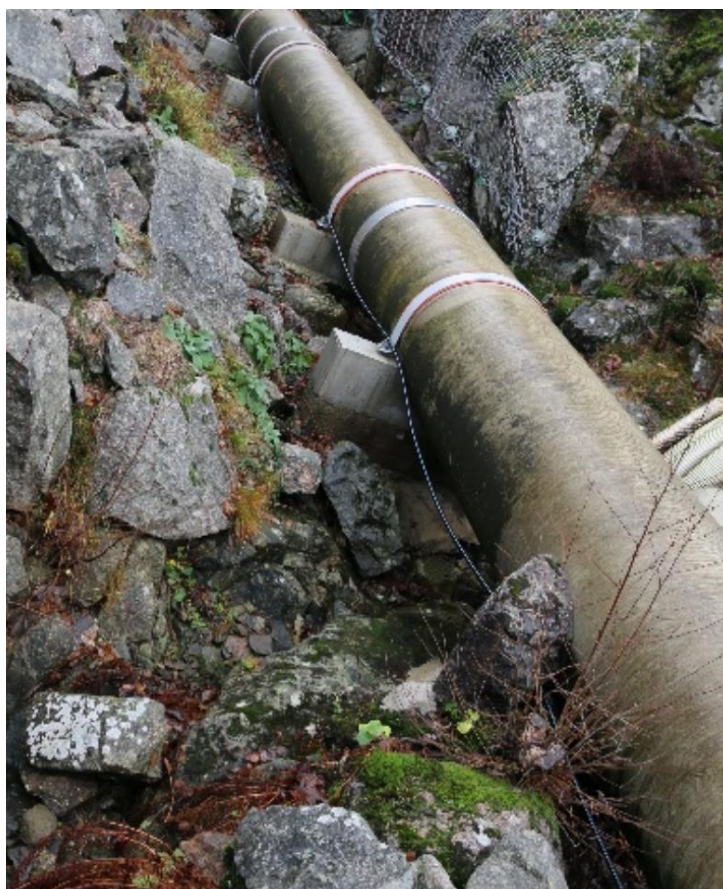
Tv. bildet er fra 2015 og viser svill, betongfundament og bånd før utskifting. Foto: Ulf Gustavsson, Riksantikvaren 2015. Th. viser detalj av støpt såle og bånd etter istandsetting.
