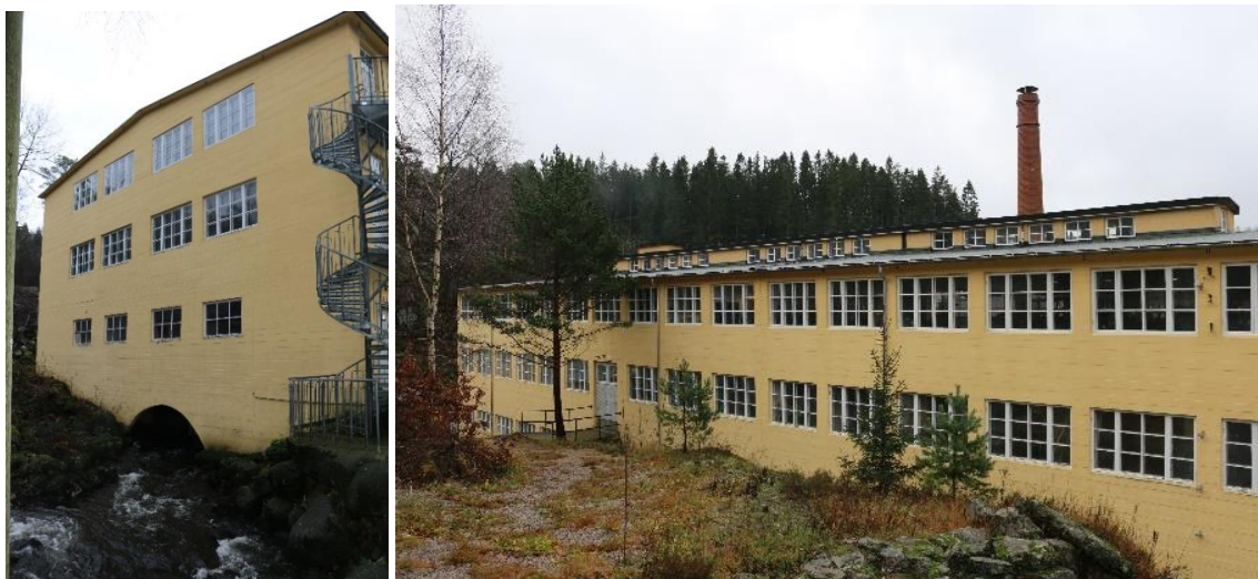
Tv. vestre vegg med tolv vinduer og åpning for spillovann fra turbinen. Th. nordre vegg.
