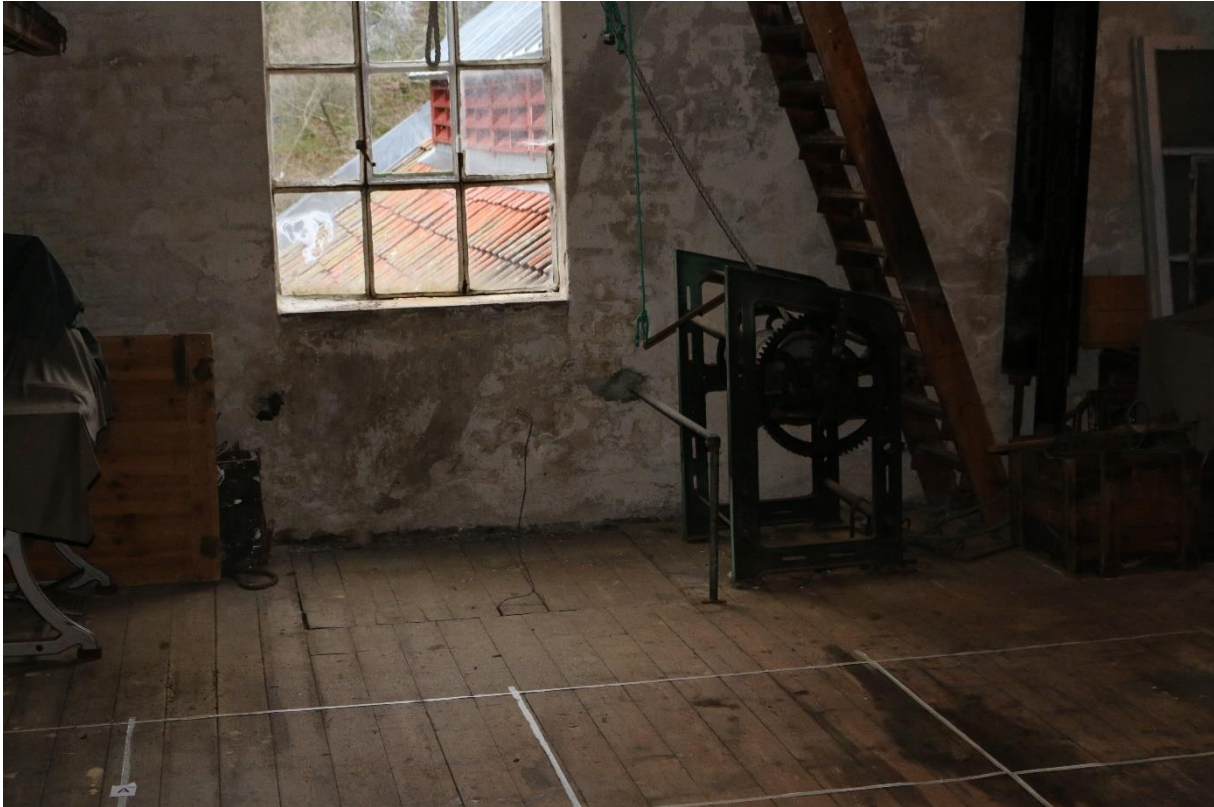
Loftsrom 5 sett mot fargeriets tak. Luke i gulv under vindu til tørrappretur og vinsj som er listet under fast inventar.
