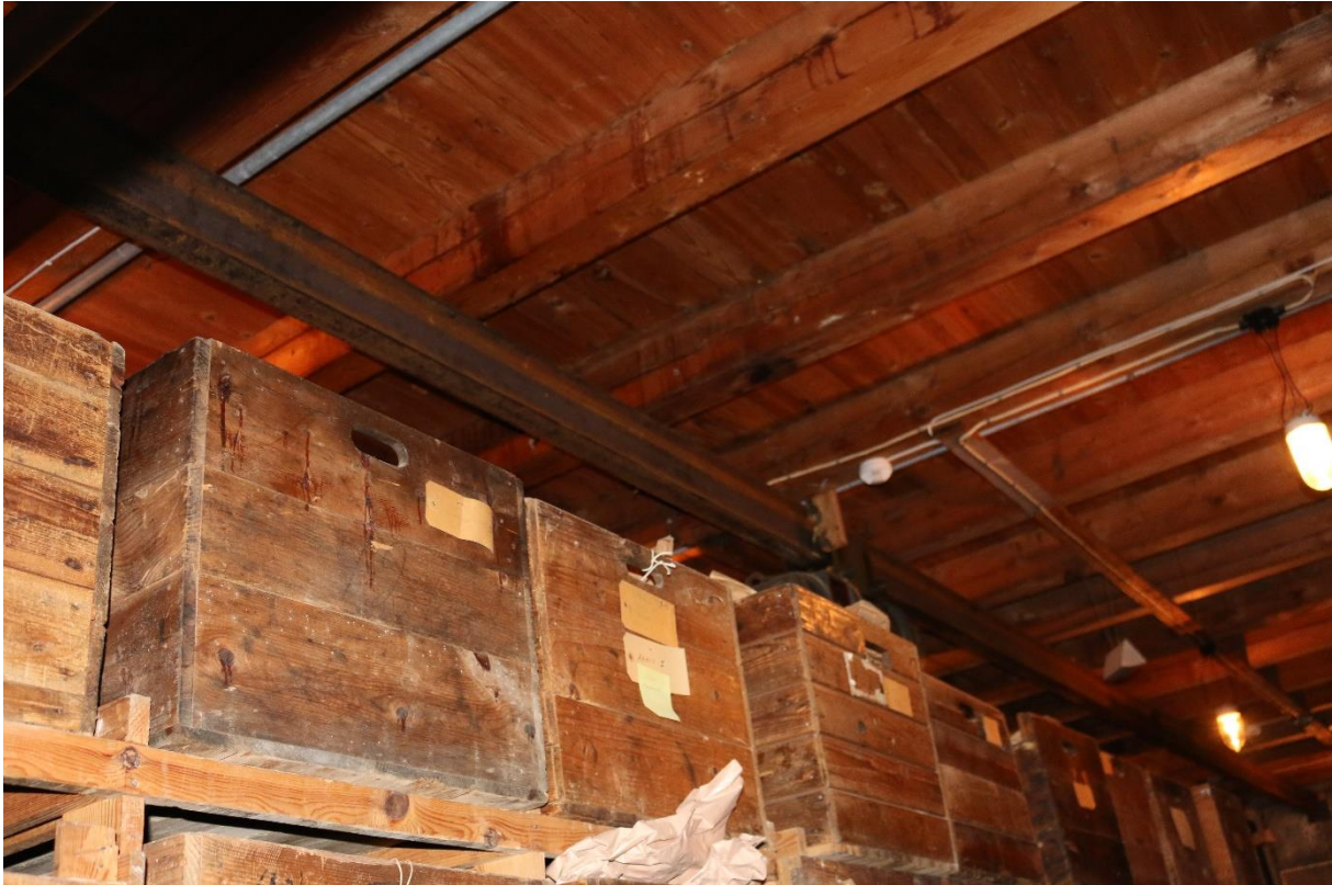
Tak og stålbjelke sett fra nord. Stålbjelken løper gjennom rommet og ut over branndøren i nordøstre vegg. Utenfor er bjelken dekket med et lite «tak». Det er festet en motor til bjelken.
