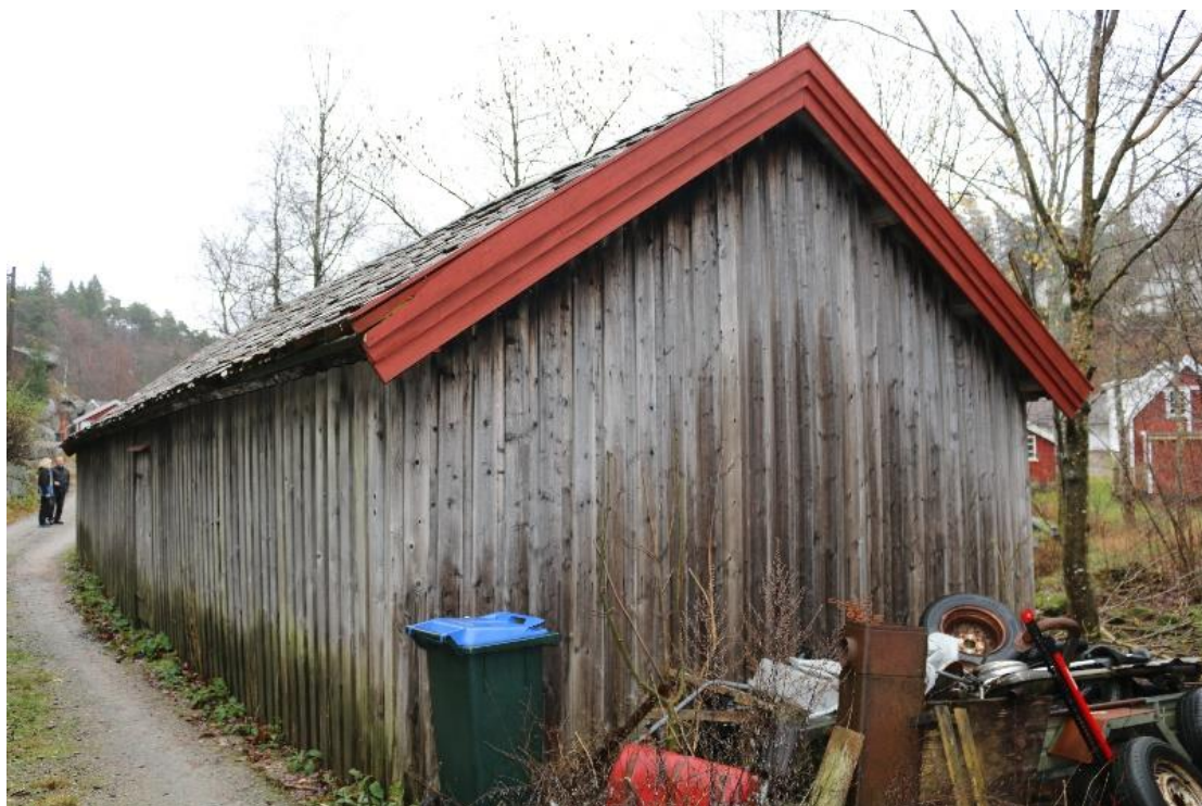
Bussgarasjen med vestre gavlvegg og vegg mot nord.
