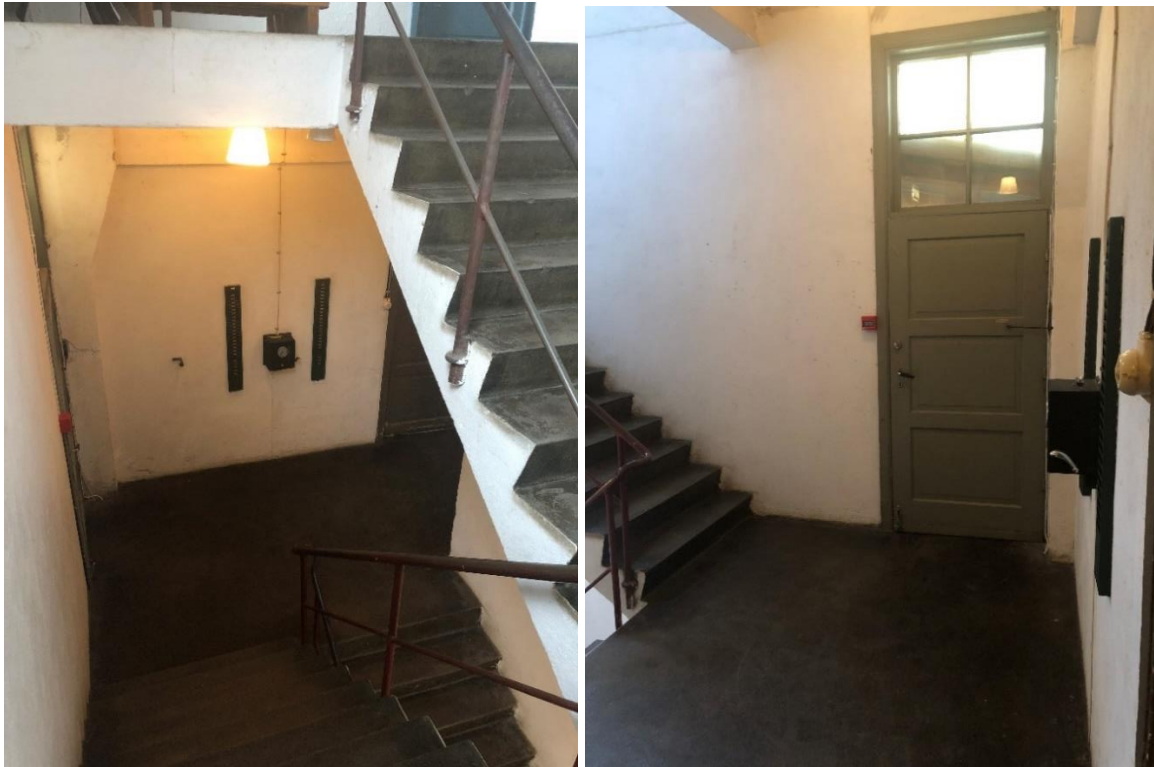
To. trapp fra tredje etasje til andre. Th. døra fører til passasjen over til garnlageret i kontorbygget. Foto: Nils Olai Romsvik-Mannes, Sjølingstad Uldvarefabrik 2019.
