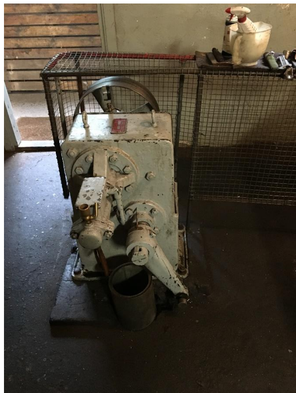
Gammel regulator for vannmengde til turbinen (19). Denne er ikke lenger i drift. Tv. sett fra øst og th. sett fra sørøst.
