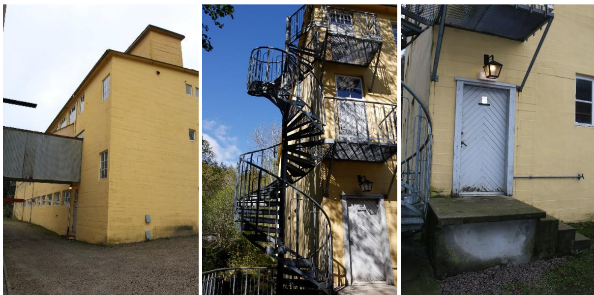
Tv. sørlig vegg sett fra sørøst, i midten detalj av spiraltrapp med dører i hver etasje (foto: Ulf Gustafsson, Riksantikvaren 2015) og th. detalj av enkel dør i første etasje ved spiraltrappen.
