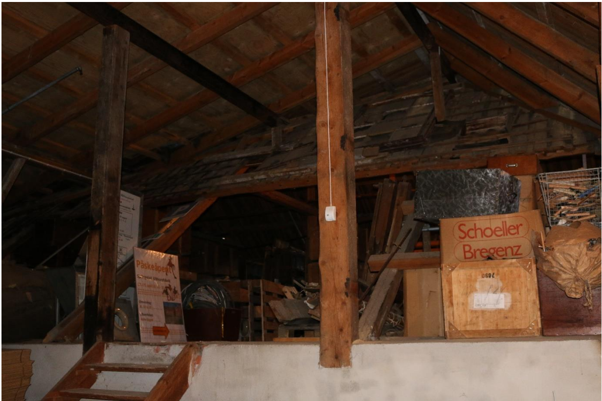
Sett fra loftet på mellombygg.
