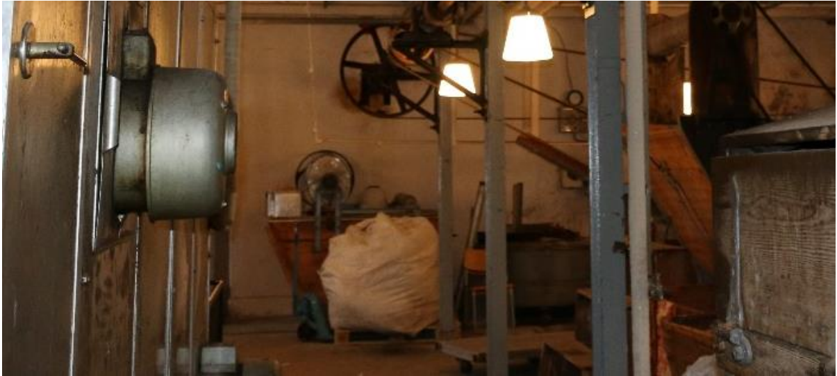
Mot veggen bak som vender mot fargeriet er maskinen to. 7. karboniseringsmaskin og th. 6. Sentrifuge.
