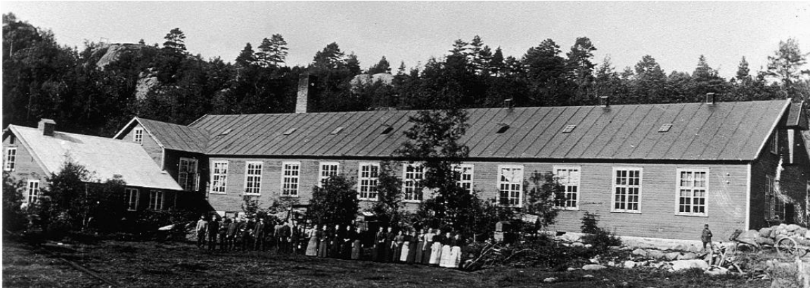
Den første fabrikkbygningen på Sjølingstad fra 1894. Foto: Vestagdermuseet
