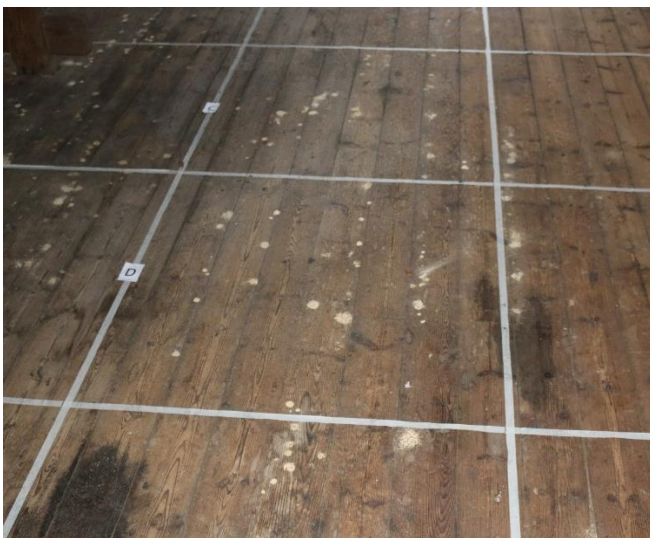
Tv. spor etter Borebiller. Det hvite rutenettet inngår i kartlegging av forekomst. Th. større løst inventar: Kuppellampe.
