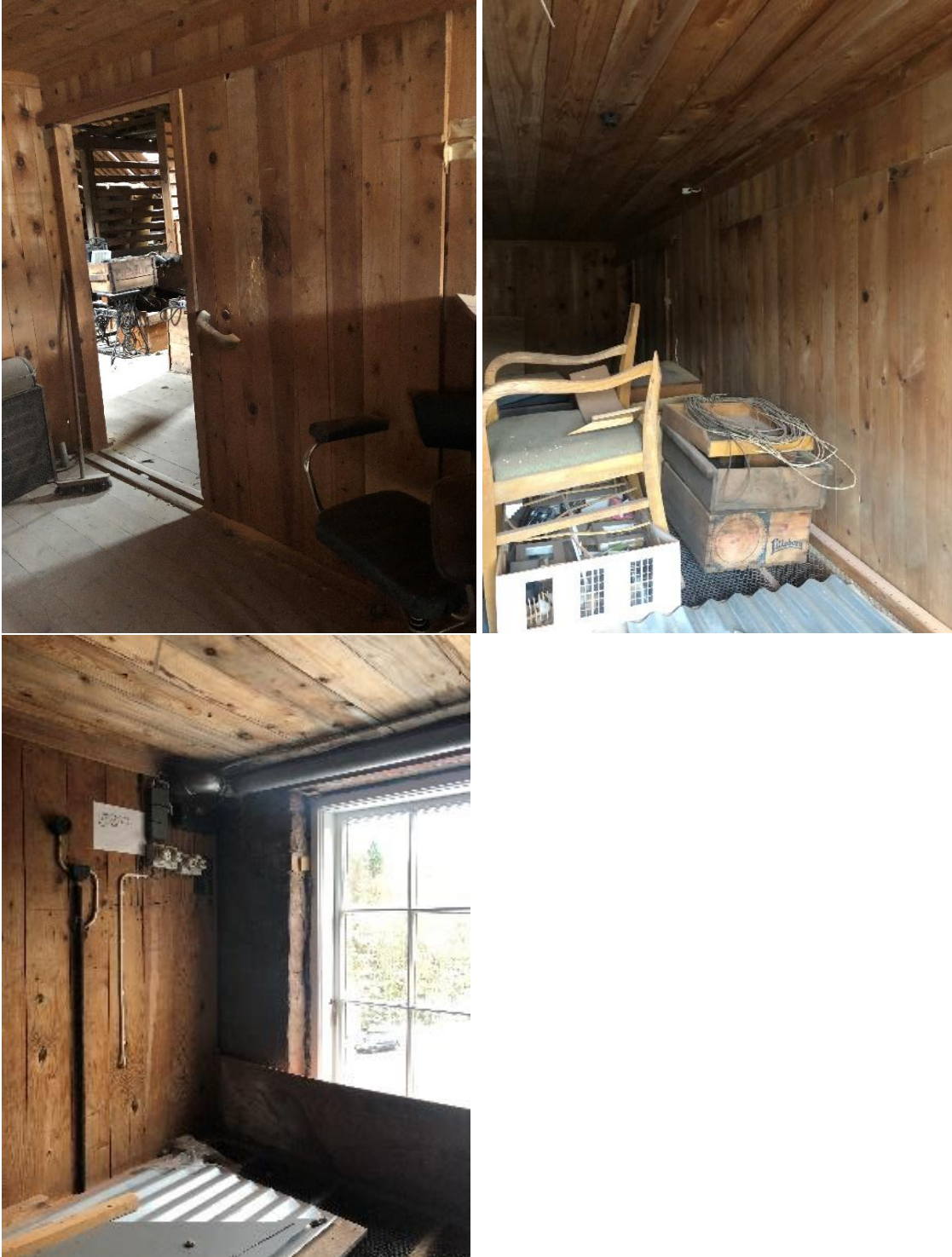
Rom 2, forberedelse til sjoddivirkosmhet. Bildet over th. og under viser litt av innretningen for fjerning av knapper, større løst inventar. Bilde tv. viser døren ut til det store loftsrommet, rom 1 – ullsorteringsbåser.
