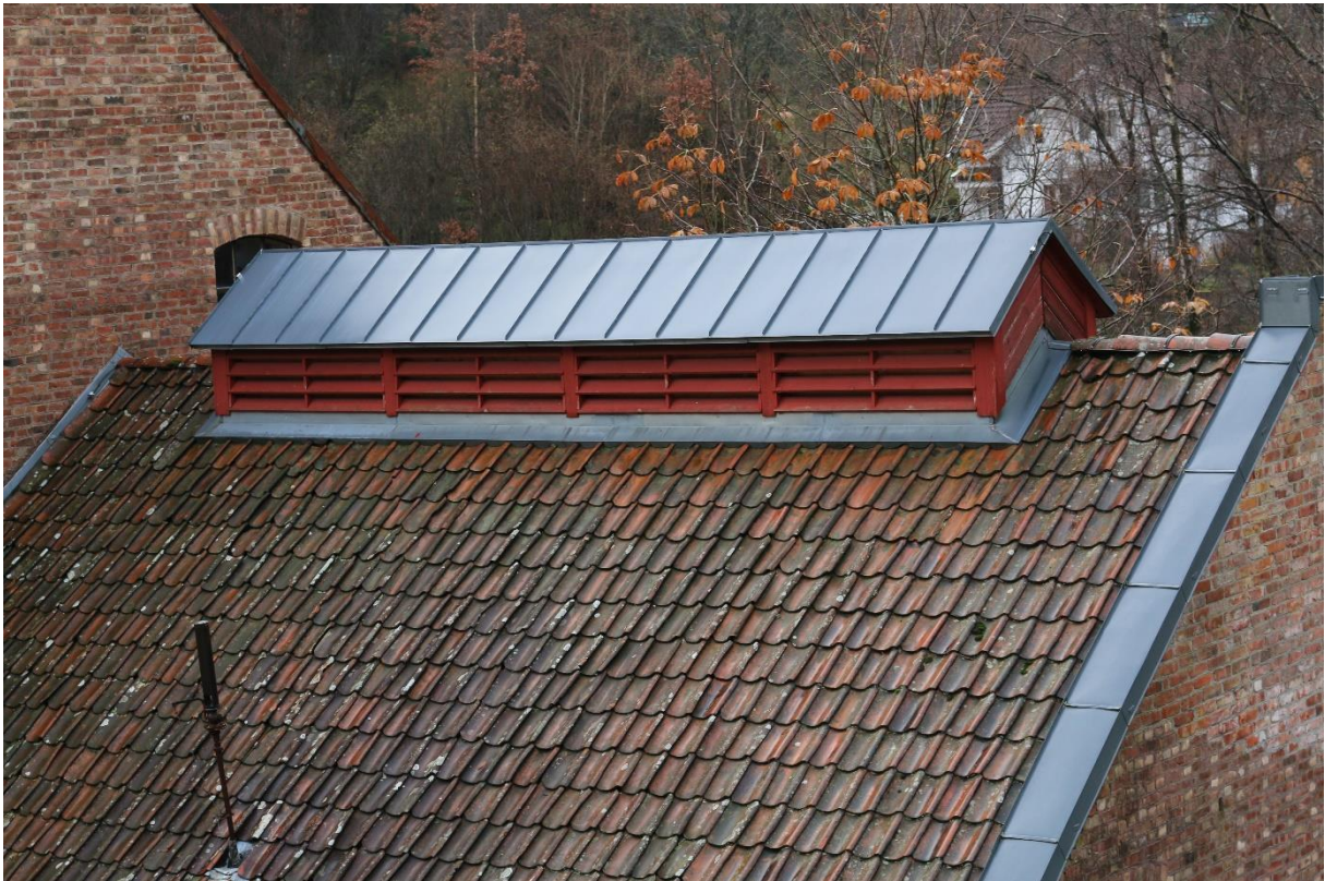
Fargeriets lufteluke på taket sett fra nord.
