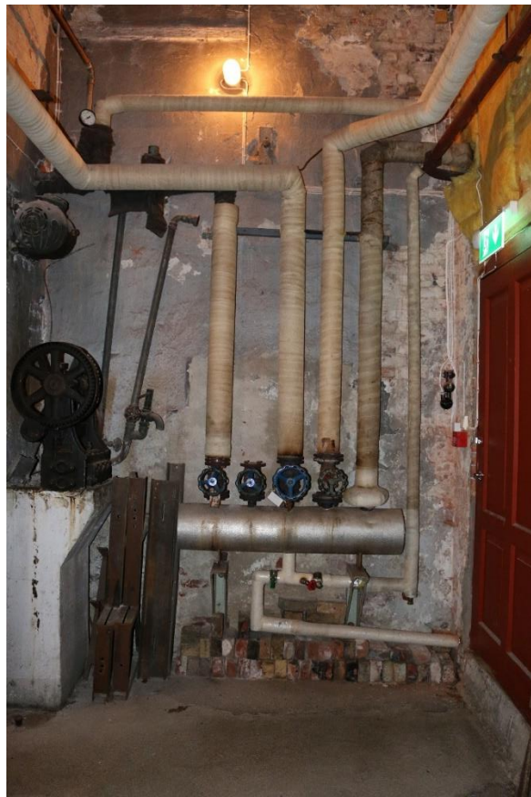
Tv. Viser tydelig såret i vegg etter at fyrkjelen ble fraktet ut. Th. rommets vegg mott vest. Innretningen på gulvet til venstre er en pumpe. Større løst inventar: lampekupler.
