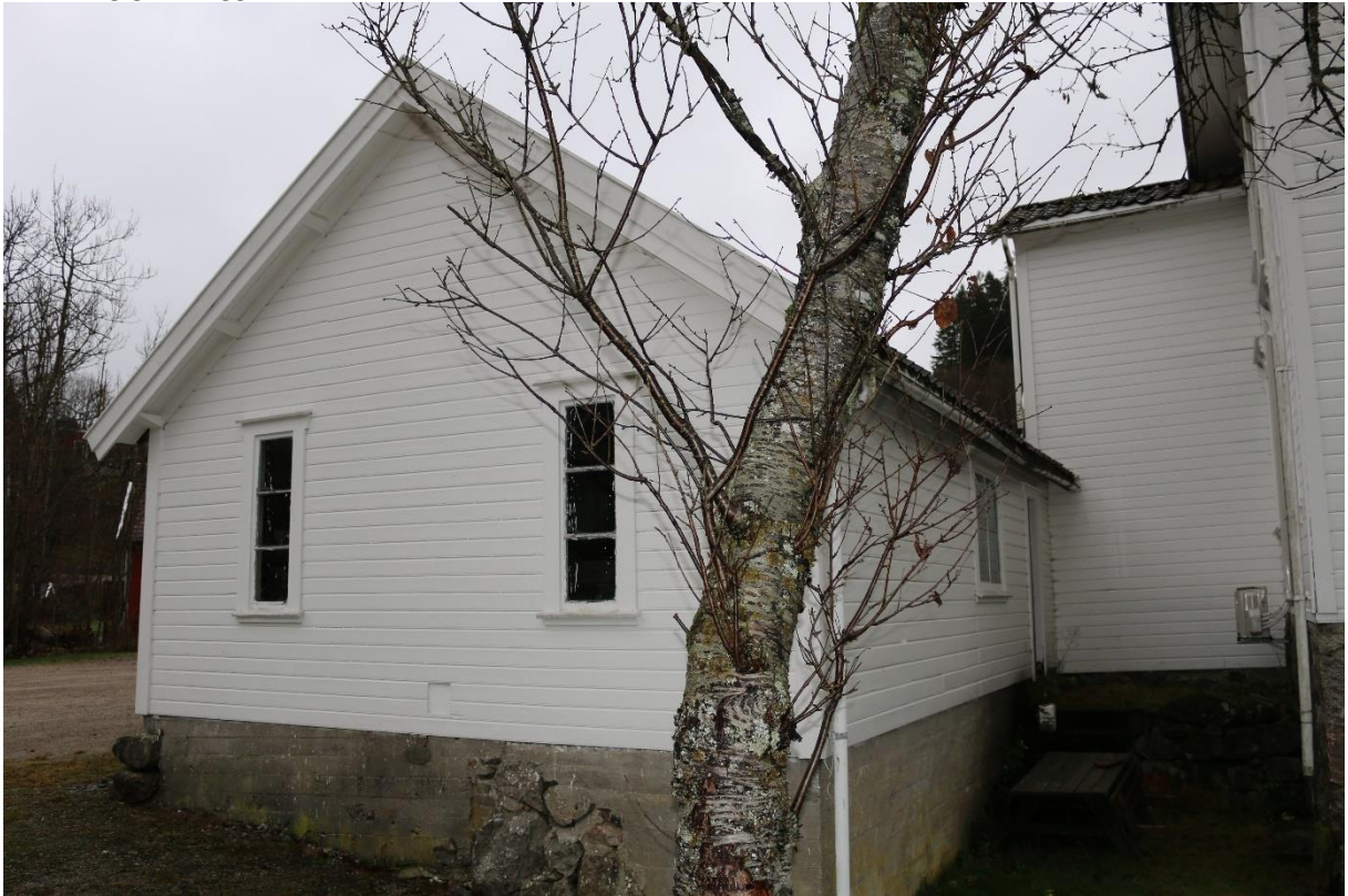
Gavlveggen mot vest og vegg mot sør.
