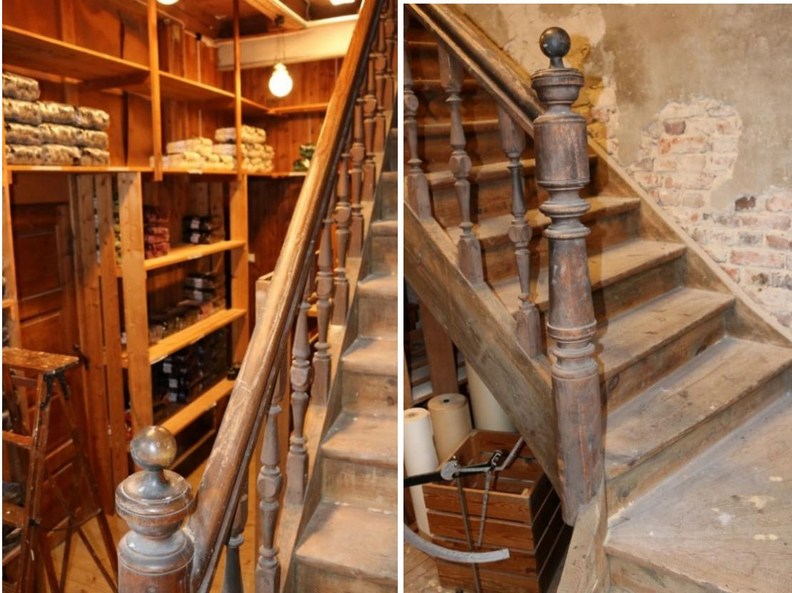
Tv. gammel inngang sett fra øst og th. trapp opp til loftet. Større løst inventar: hengende lampekupler.
