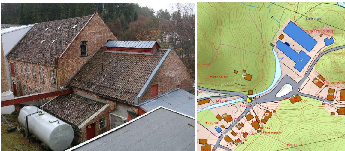
Tv. smia er det lille tilbygget ved tanken, her sett fra kjelebygget. Th. viser hvor smia befinner seg relatert til øvrig bygningsmasse.
