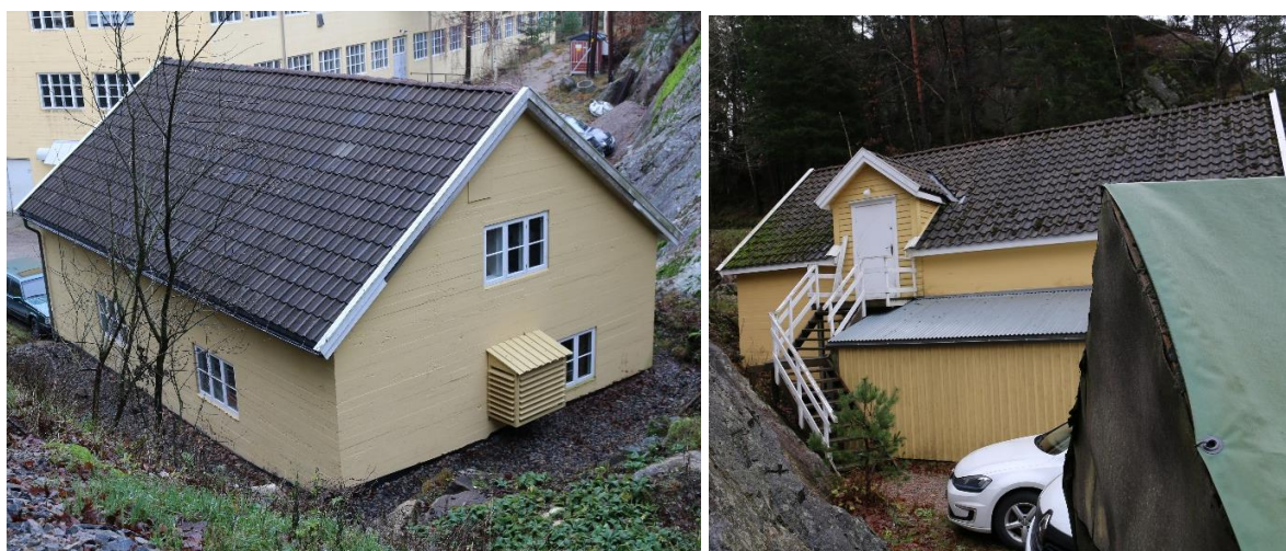
Tv. nordøstre og sørøstre vegg. Th. nordvestre vegg.
