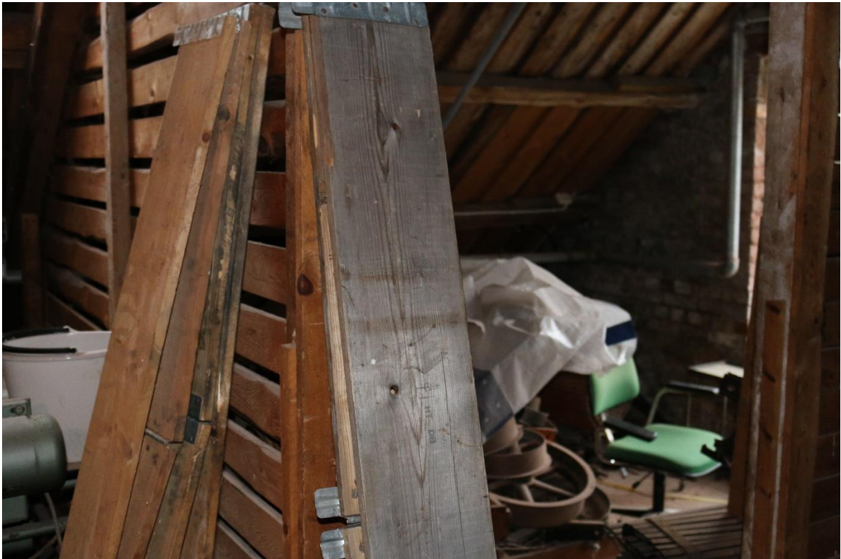
Bås ved siden av dobbeltdør.
