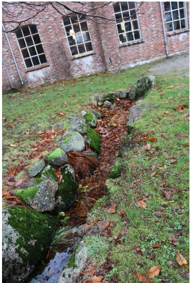
Detaljer av forfall, fuktproblematikk ved sørlig vegg.
