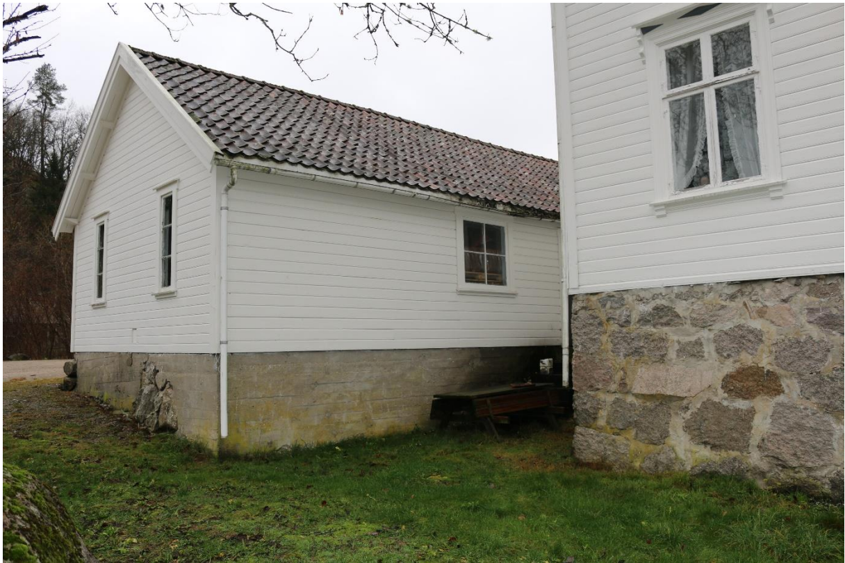
Gavlveggen mot vest og vegg mot sør.
