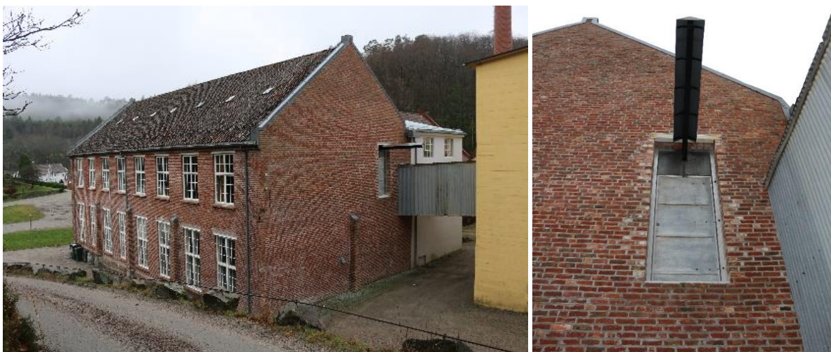
Tv. kontorbyggets østvegg med vinduer. Th. detalj av metalldør på nordvegg.
