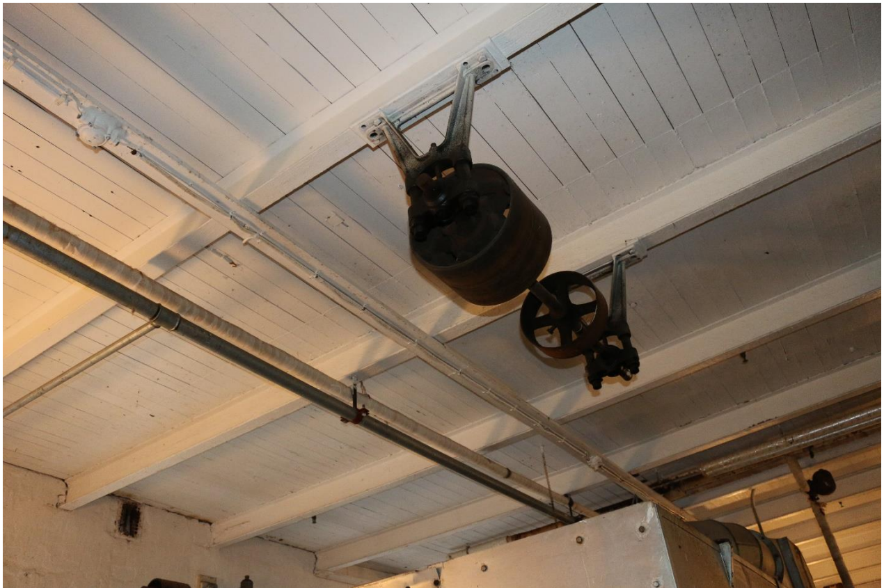
Detalj av reimtrinser i taket.
