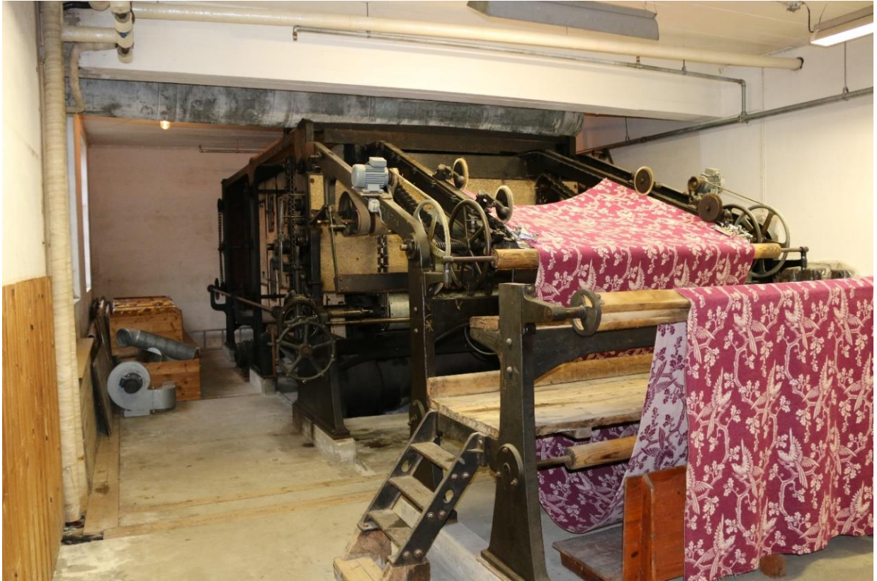
Tørkemaskinen (1), sett fra vest.
