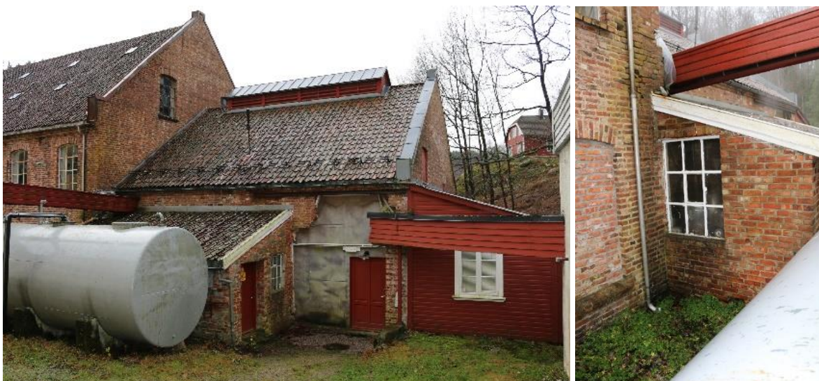
Tv. Smias dør og vindu i vestre vegg. Th. vindu i østre vegg.
