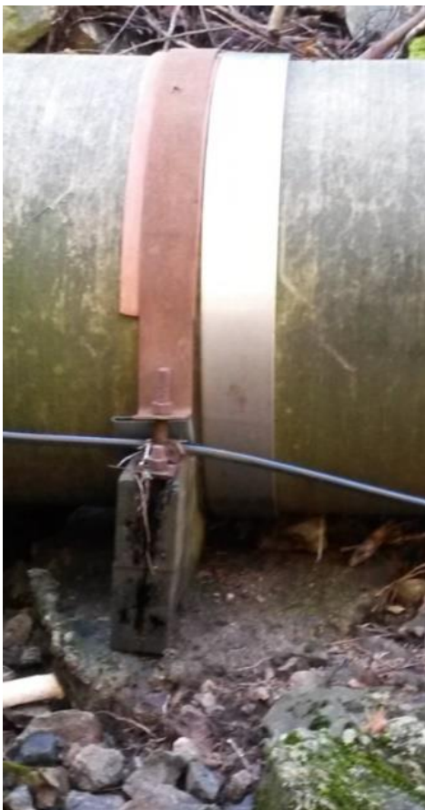
Tv. bildet er fra 2015 og viser svill, betongfundament og bånd før utskifting. Foto: Ulf Gustavsson, Riksantikvaren 2015. Th. viser detalj av støpt såle og bånd etter istandsetting.
