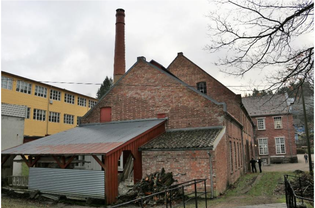
Gavlsvegg mot øst. I forkant vises tilbyggene med pulttak.
