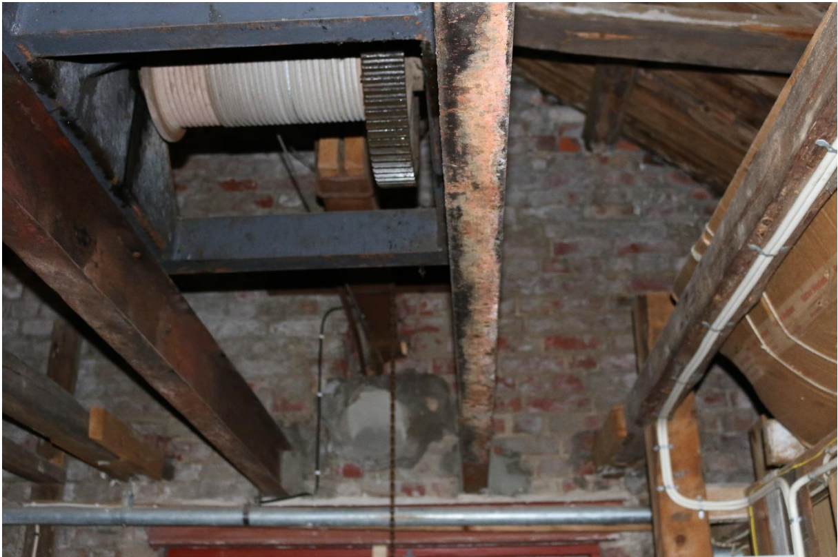
Vinsj sett fra nordøst. Større løst inventar.
