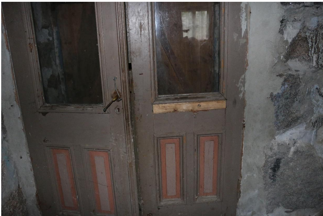
Indre dobbeltdør til kjeller, sett fra kjellerrommet.
