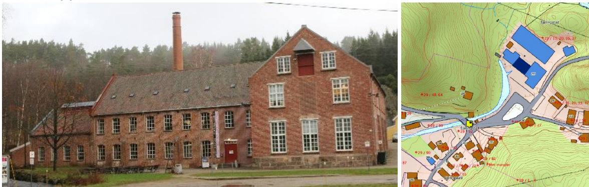
Appreturbyggets vegg mot sør.
