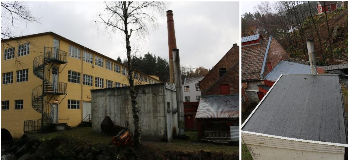
Tv. søndre vegg av kjelebygg med dør og pipe. Th. i 2008 ble det lagt ny shingel på taket.
