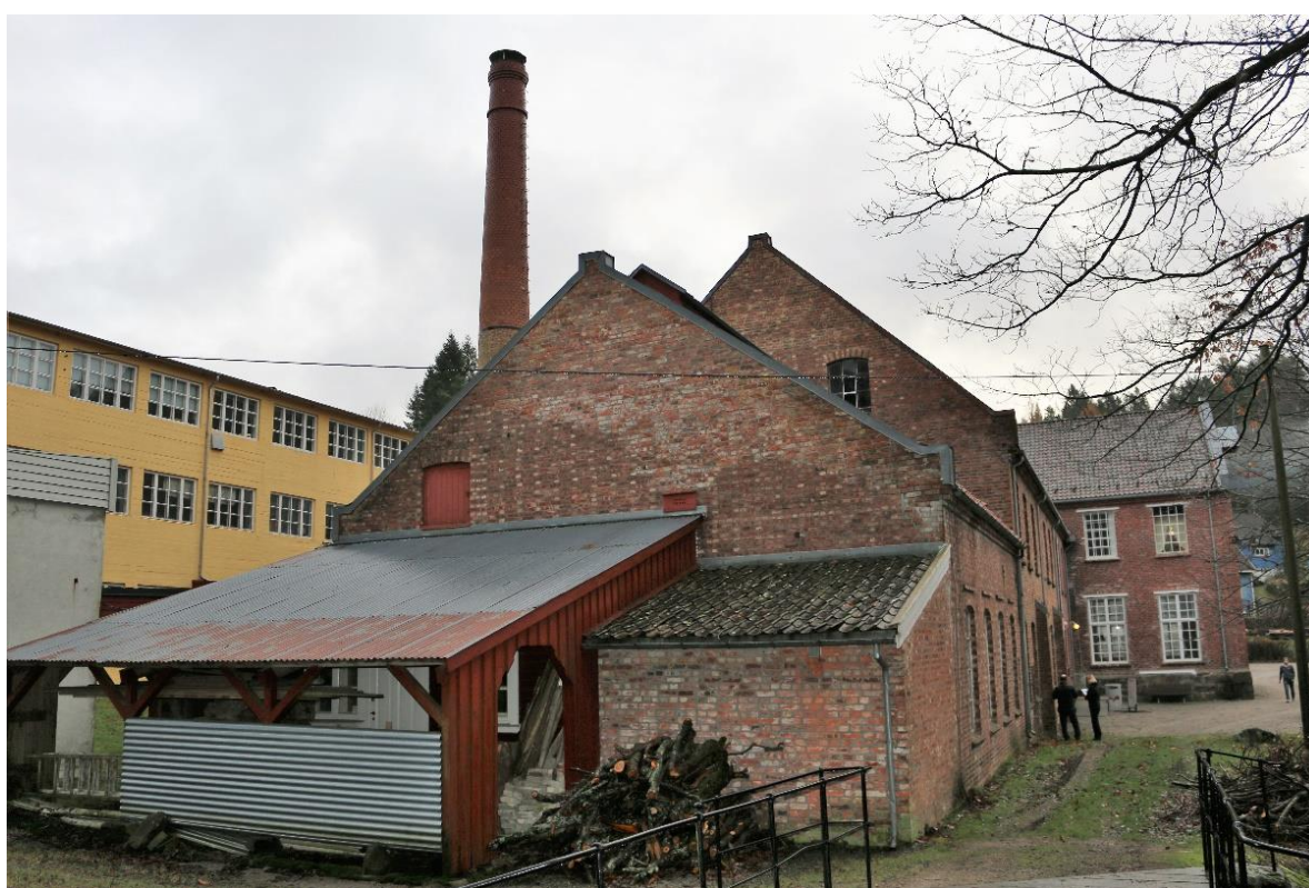
Veggen i bakkant med fire vinduer er kontorbyggets vegg mot nordvest.
