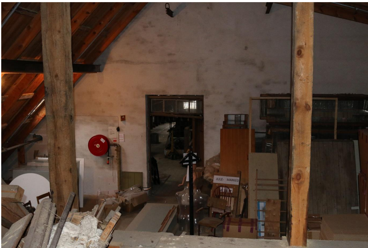
Rom 4 sett fra kontorbyggets loft, sett mot appreturbyggets loft.
