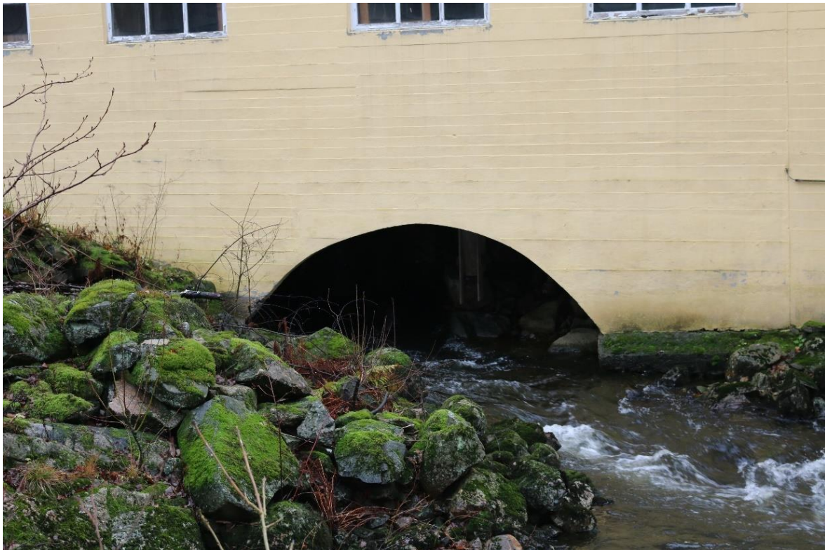
Vannet renner ut mot Sjølingstadbekken igjen etter omveien gjennom rørgata og turbinen.
