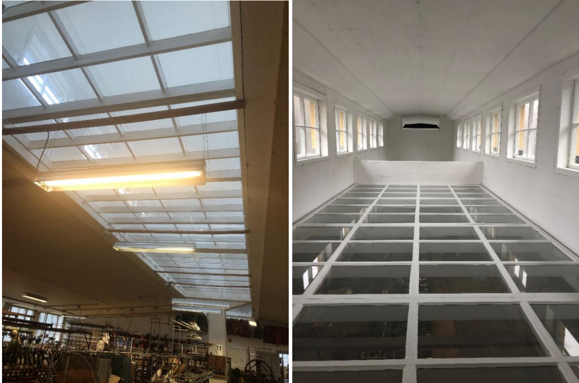
Lyssjakt i spoleriet sett tv. nedenfra og th. ovenfra. Foto: Nils Olai Romsvik-Mannes, Sjølingstad Uldvarefabrik 2019
