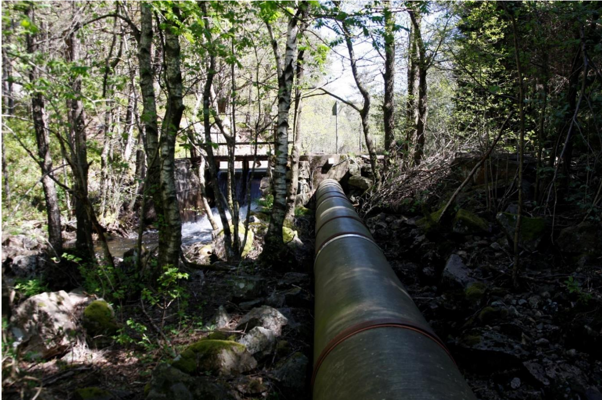
Rørgata sett fra vest. Foto: Ulf Gustavsson, Riksantikvaren 2015.
