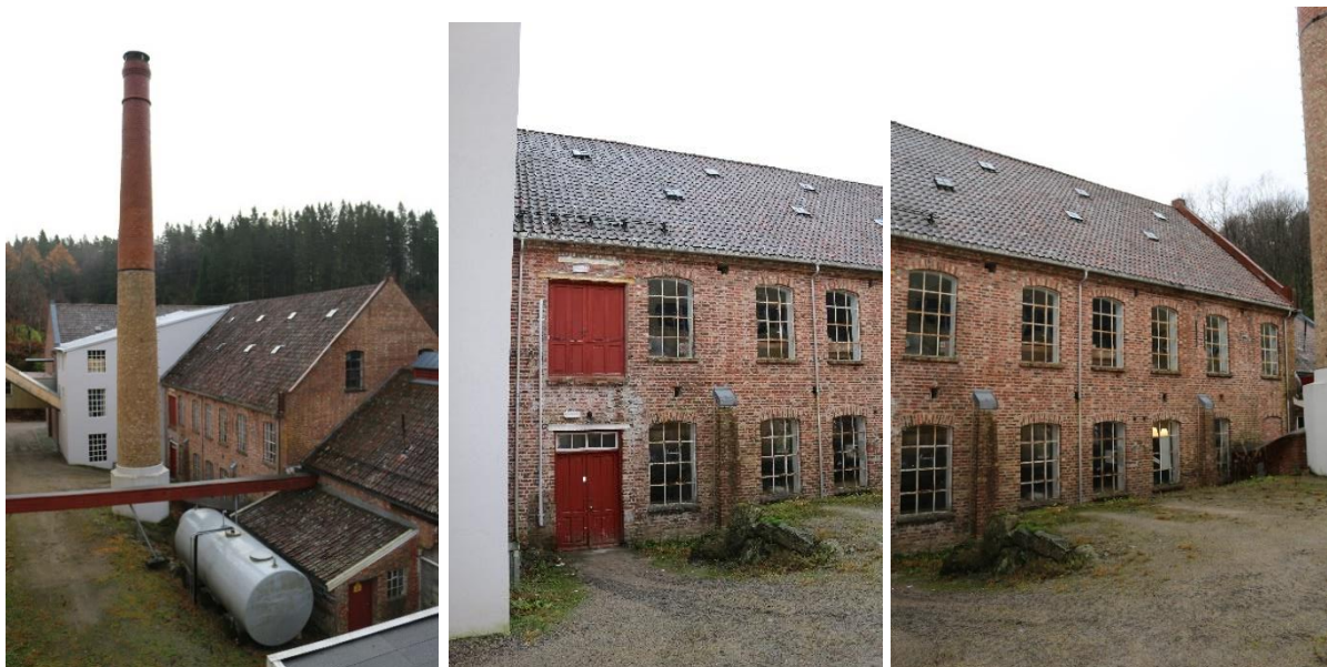
Tv. Appreturbygget, gavlveggen mot vest og nordveggen. I midten vises portene og en rekke vinduer på nordveggen samt takluker. Th. vinduer i nordre vegg og takluker.
