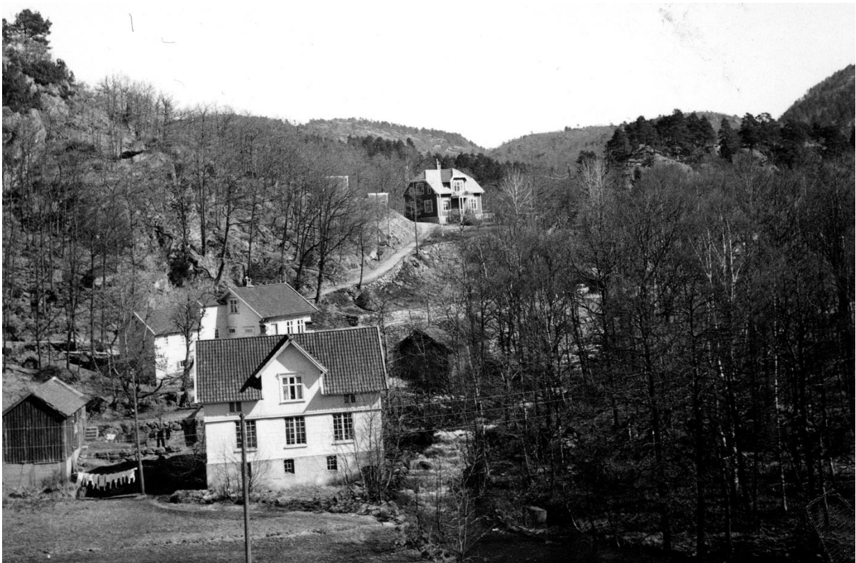
I forgrunnen er den nye treskofabrikken satt opp i 1924 etter at den gamle brant i 1923. Til høyre bak fabrikken, ligger bussgarasjen ved Sjølingstadbekken. Foto: Lindesnes Bygdemuseum/agderbilder.no
