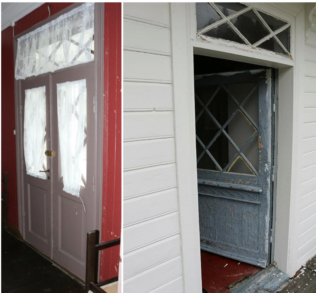
Tv. Dobbeltdør til veranda på sørlig vegg i første etasje, sett innenifra. Th. verandadør i andre etasje, sett utenifra.
