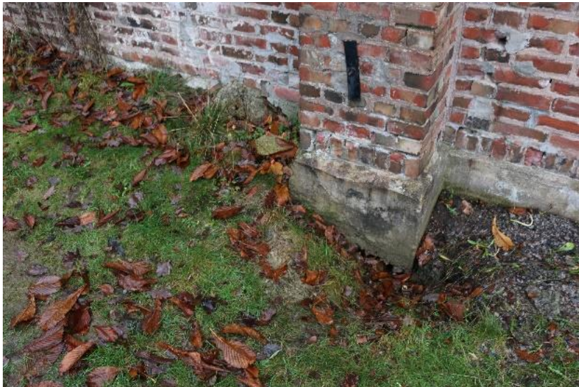
Detaljer av forfall, fuktproblematikk ved sørlig vegg.
