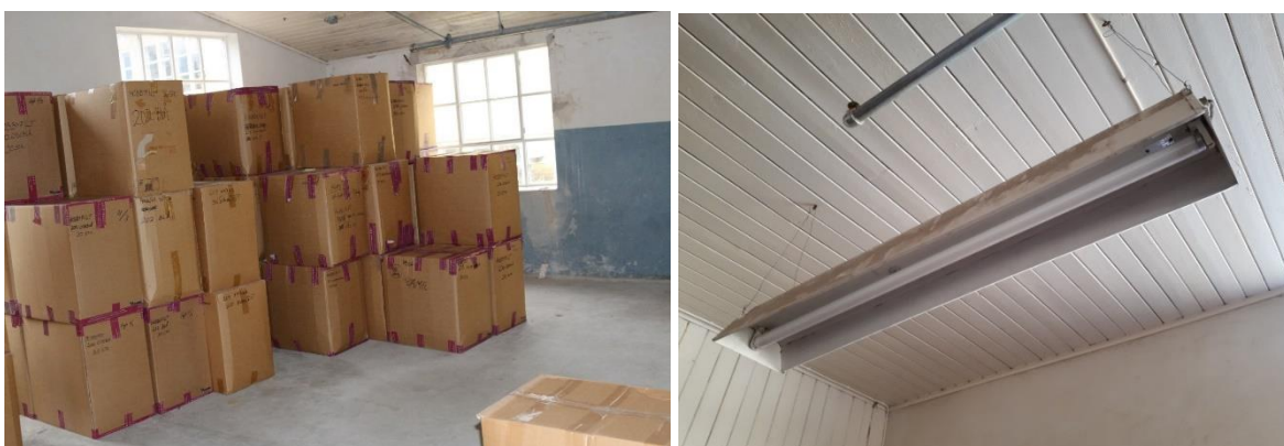
Rom 3 sett mot nordvestre hjørne. Th. større løst inventar: Armatur.
