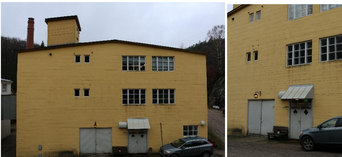
Tv. Gavlsvegg mot øst. Th. detalj av port og dør.
