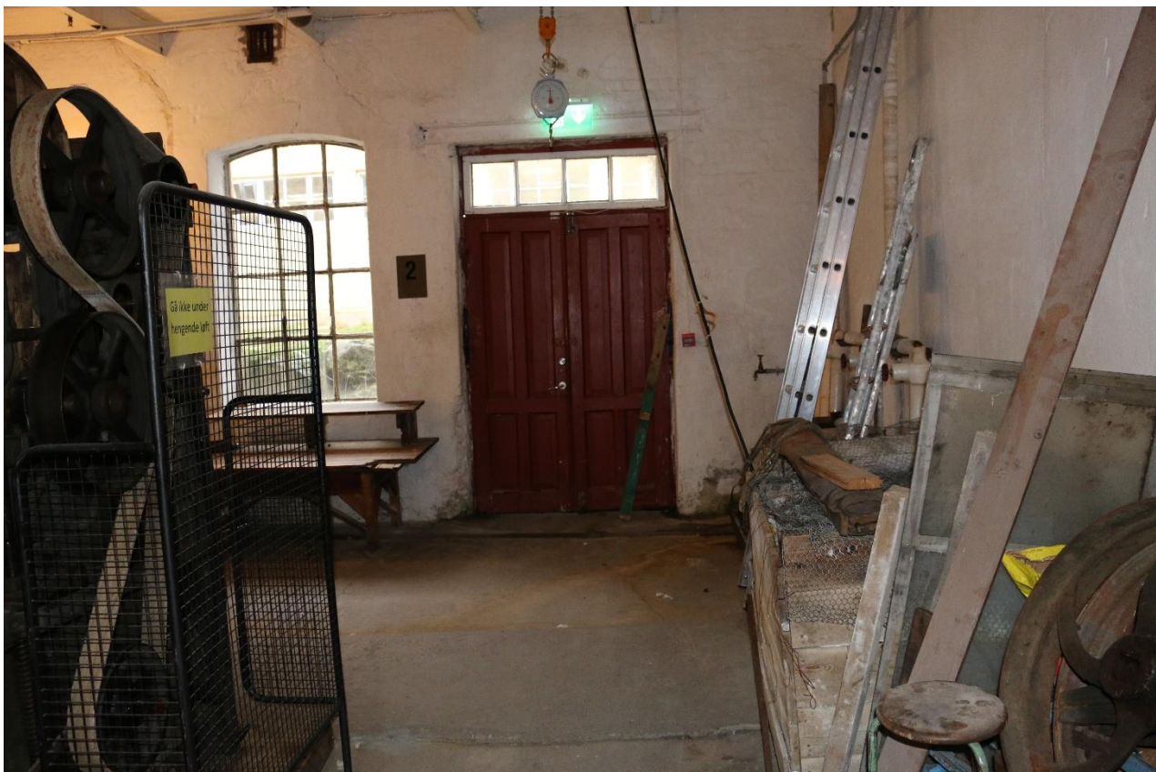
Dobbel dør ut til gårdsrommet mot spinneribygget.
