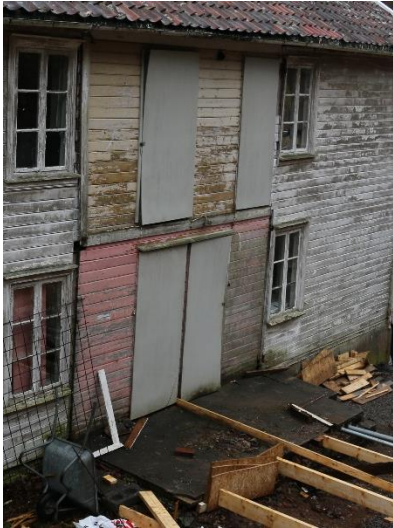
Tv. på nordre vegg er det tydelige spor etter trappehuset som er revet. Th. Gavlsvegg mot vest og fasade mot sør.
