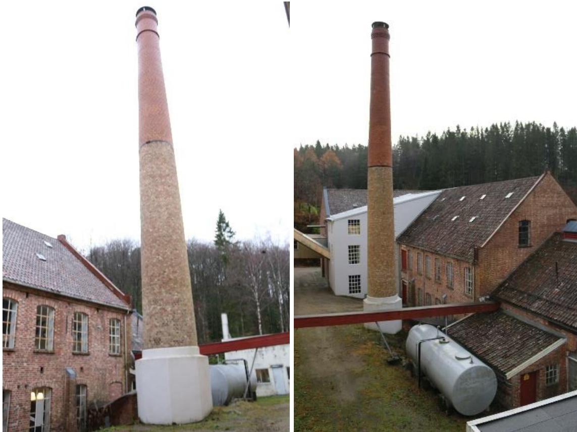
Tv. fabrikkpipa sett mot vest. Th. og mot øst.
