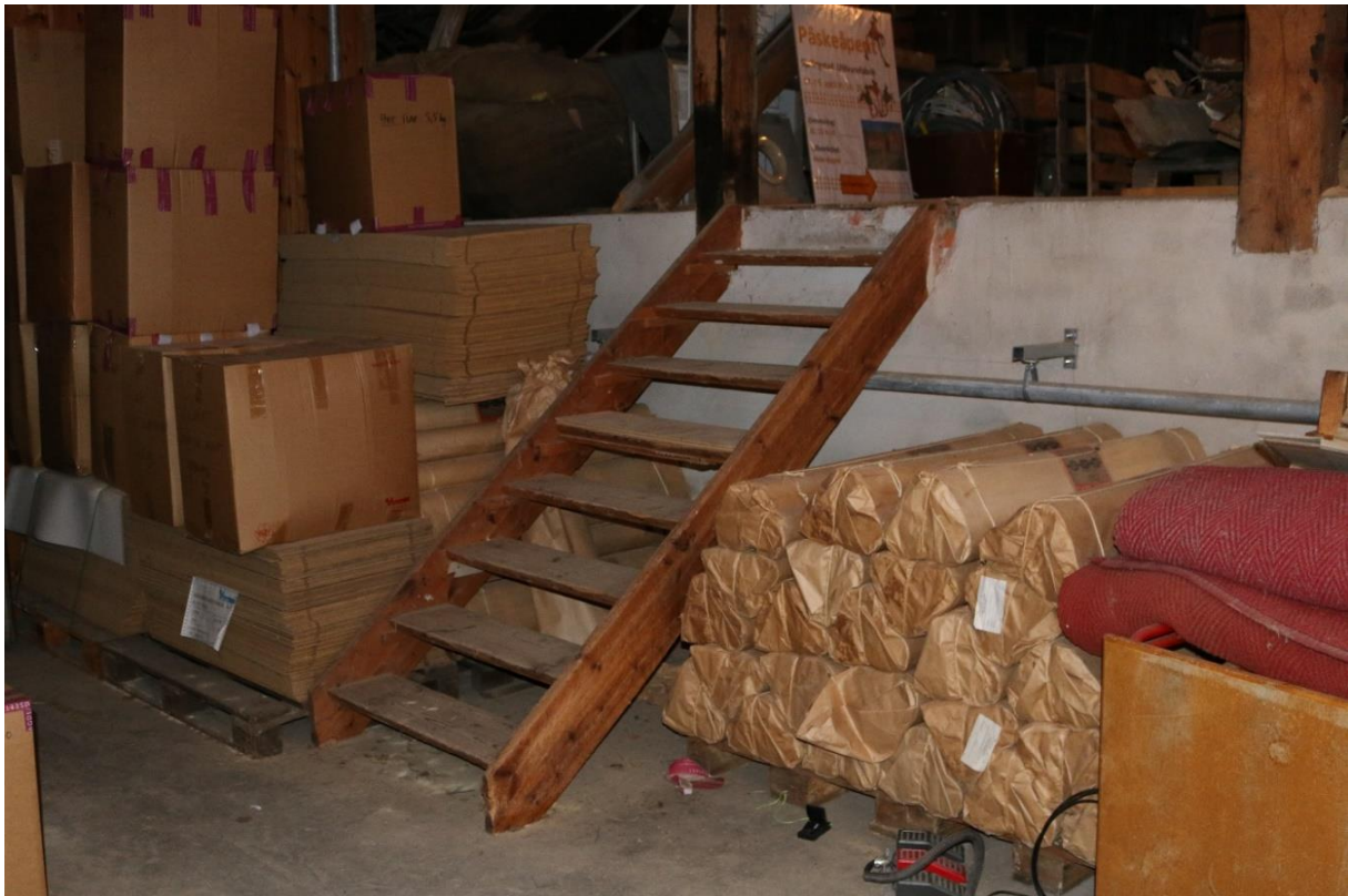
Trapp opp fra rom 4 til loftet over kontorbygg, rom 1.
