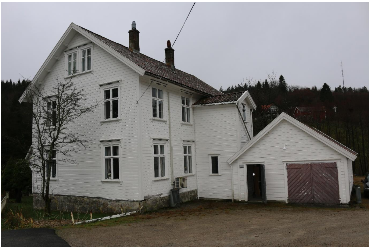
Disponentboligen, gaolssvegg mot øst og vegg mot nord med trappehus.
