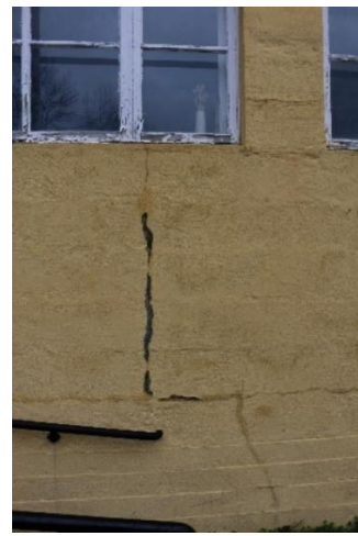
Tv. dobbeltdøra i første etasje på søndre vegg (foto: Ulf Gustafsson, Riksantikvaren 2015). Th. Detalj av sprekkdannelse i søndre vegg under vindu nær dobbeltdøra.
