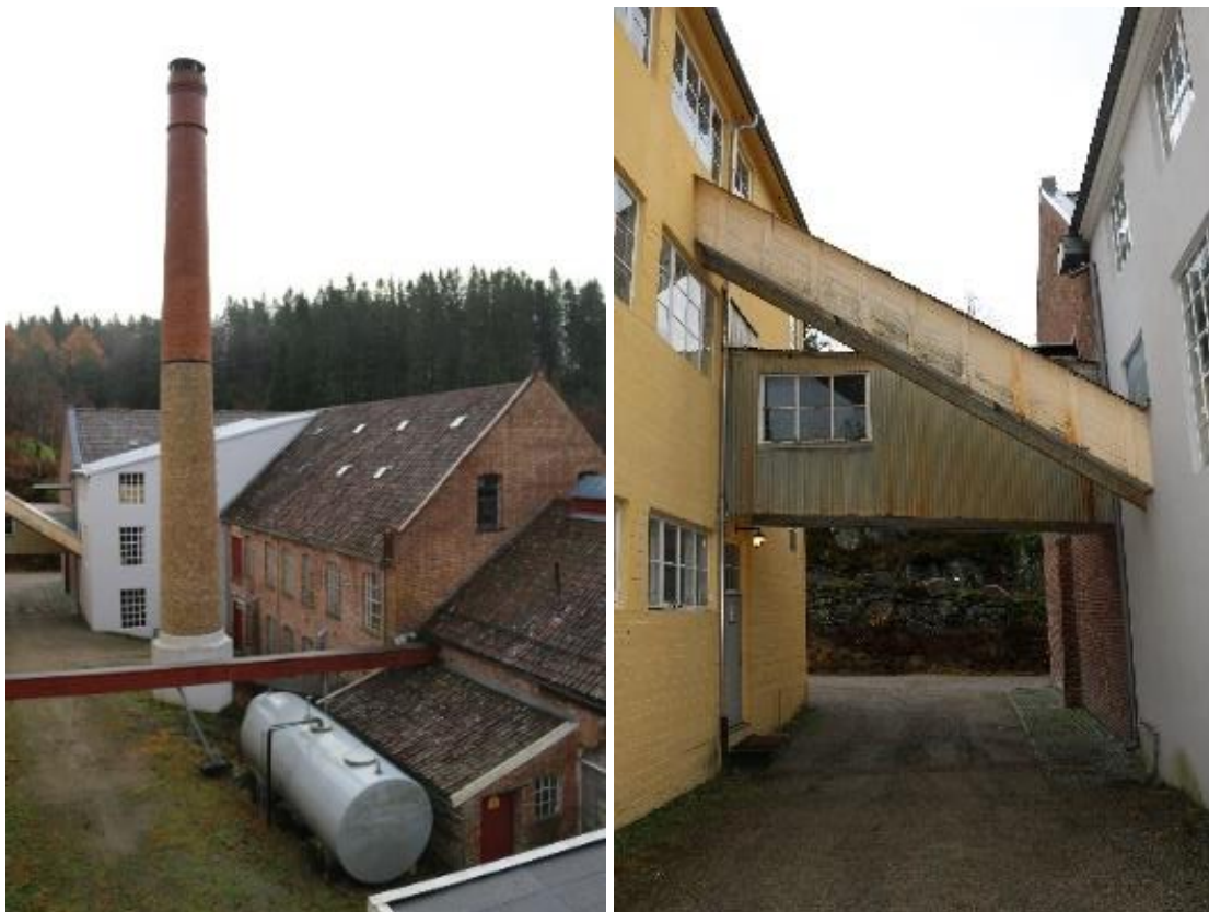
Tv. mellombyggets vegg mot nordvest, i hvitmalt betong. Th. detalj av transportskje for ferdigvovde stoffer fra spinneribygget, som er gult, til mellombygg.
