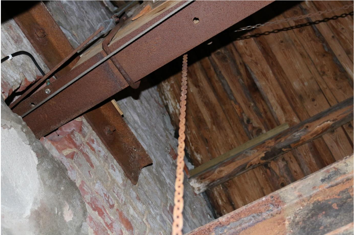
Bjelke tilknyttet vinsj ved sørvestre yttervegg. Ble benyttet til å heise ullsekker opp til loftet.
