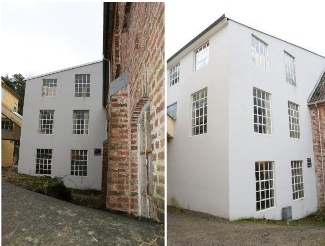
Tv. mellombyggets betongfasade på vestvegg og th. viser vest- og nordvegg.
