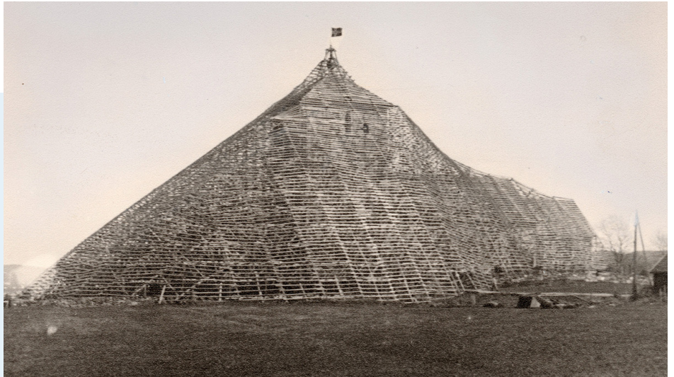
Avaldsnes kirke under andre verdenskrig, dekket til for beskyttelse.
