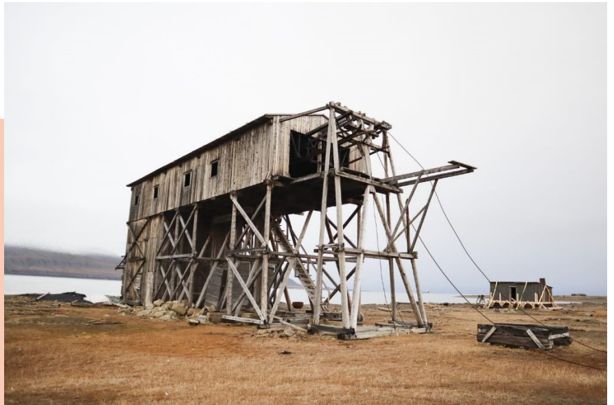
Hiorthhamn Taubanestasjon på Svalbard. Foto: Edvard Undall, NIKU
