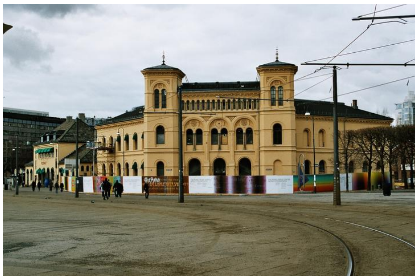
Fasade mot nord og øst. Opphavsrett: Statsbygg.
